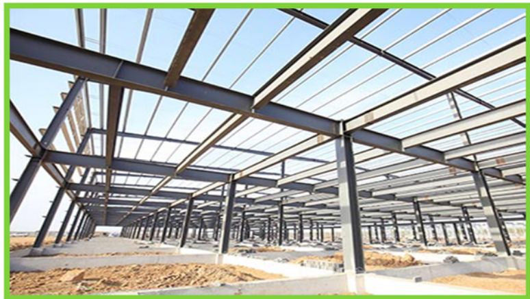
Fig 122: La structure métallique
