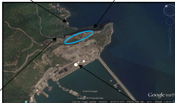
Vue aérienne du site source: Google Earth
