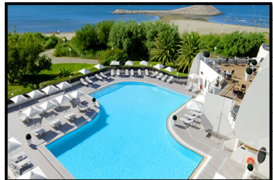
La piscine du centre source: www.lagrandemotte-architecture.com
