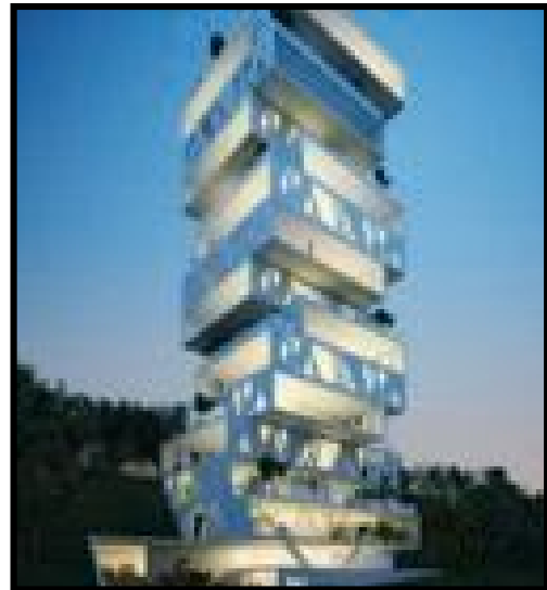
Le cube source: fr.wikiarquitectura
