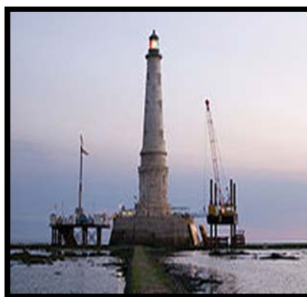
Les travaux de renforcement du phare Source: http://www.wikimedia.org
