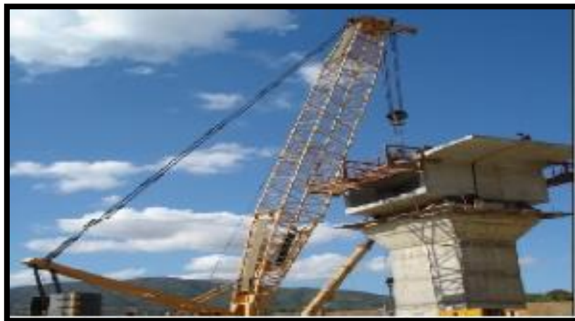
Fig. II.4 : La pose des voussoirs par grue.
