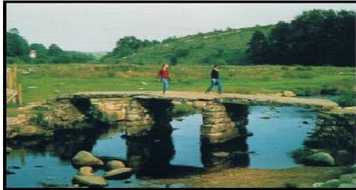
Fig. I.3. L'un des premiers ponts de pierre à Structure montants-linteau.
