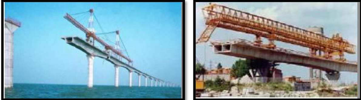
Fig. II.3. Construction du viaduc de l'Ile de Ré à l'aide d'une poutre de lancement.
