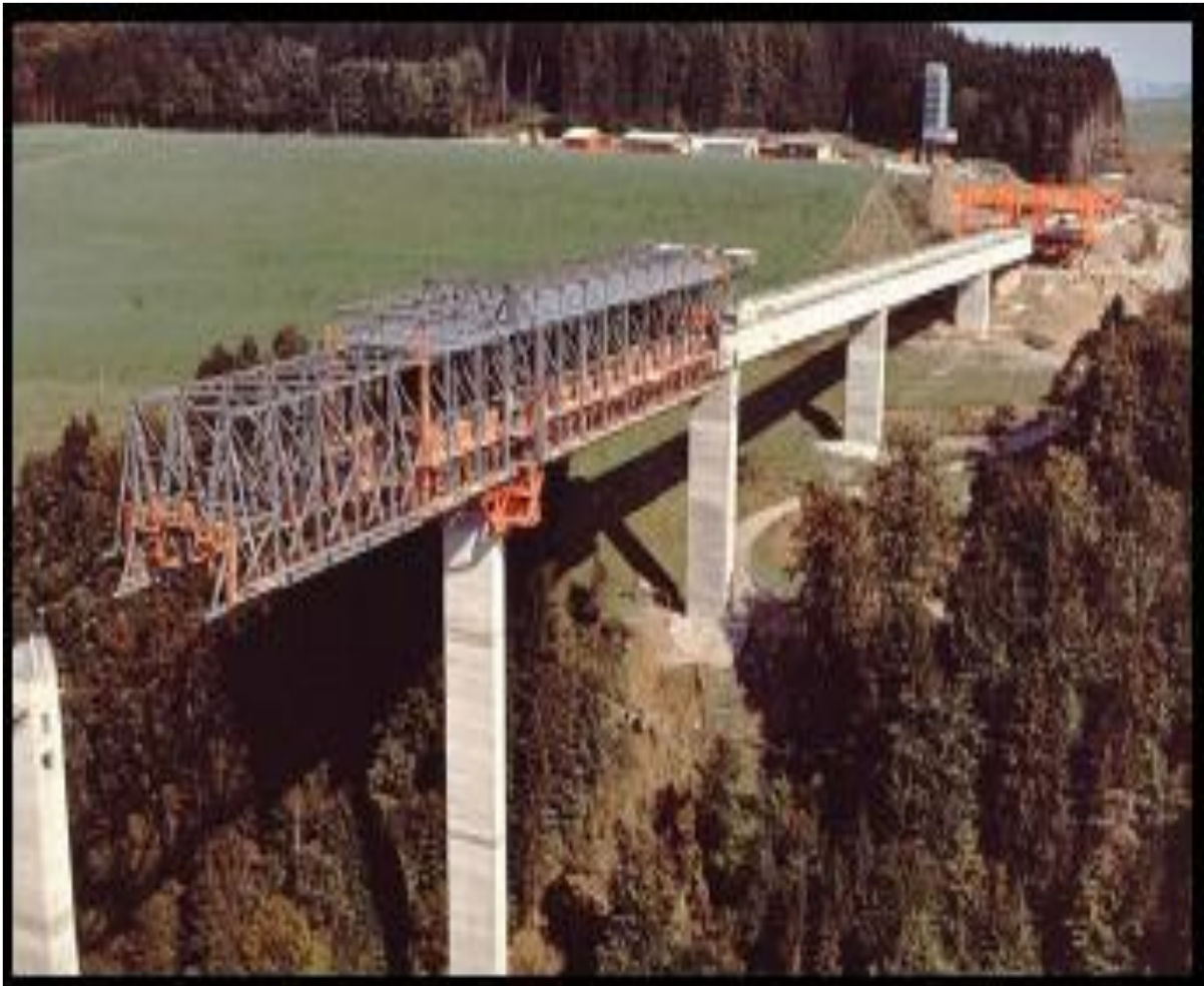
Fig. II.7. Construction par poussage.
