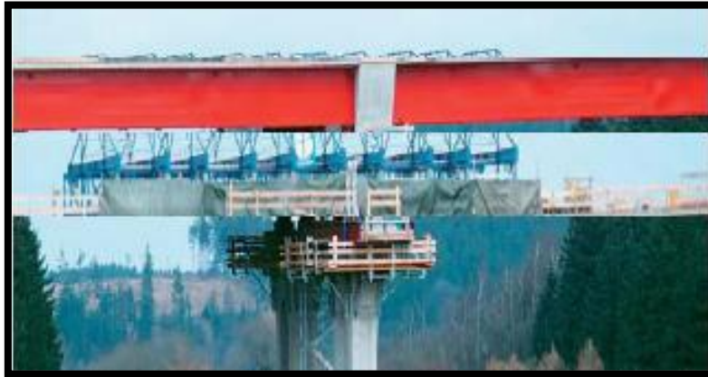
Fig. II.6. Tablier coulé sur cintre.
