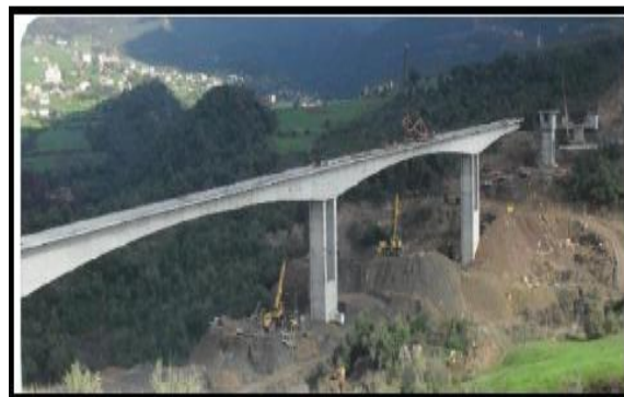
Viaduc D'Oued Rekham (BOUIRA EN 2008)
