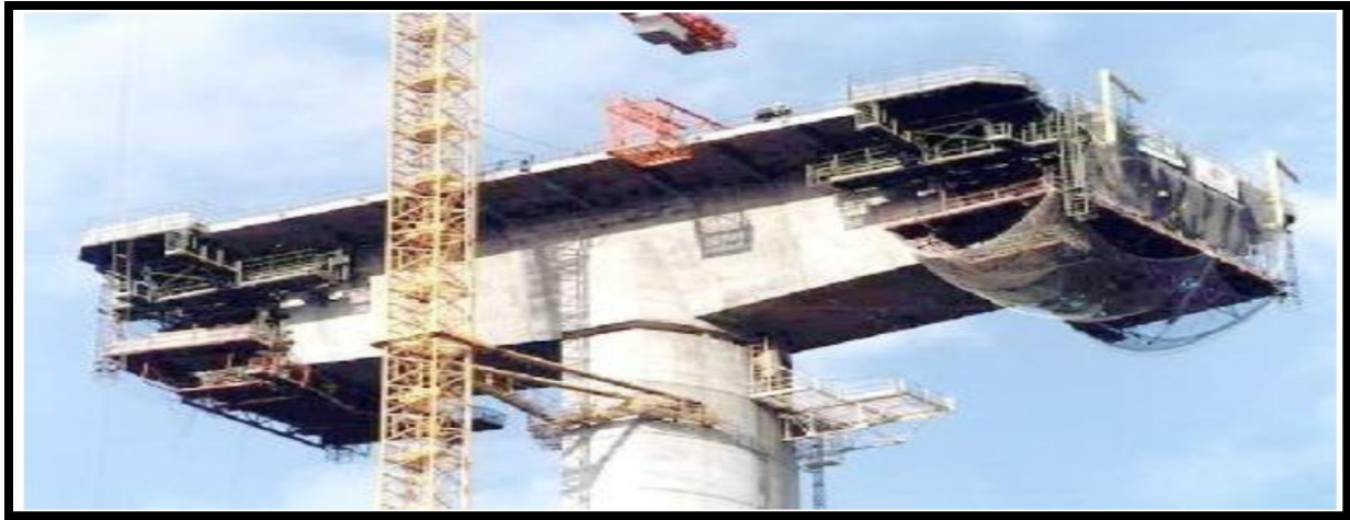
Fig. II.1. Deux équipages mobiles.
