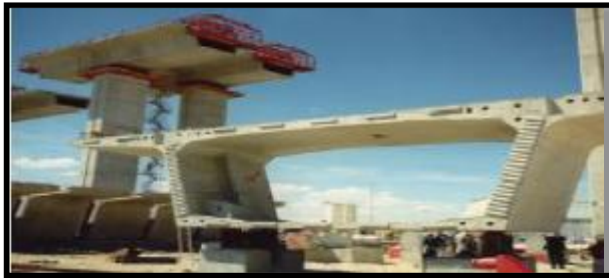
Fig. II.2. Voussoir préfabriqué
