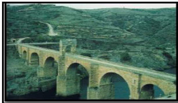
Fig. I.4. Puent Alcantara sur le Tage (98 apr. J. C).
