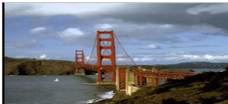
Fig. I.6. Pont suspendu « Golden Gate » achevé en 1937.
