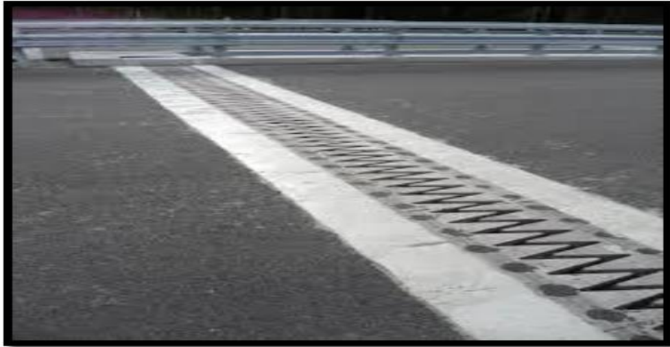
Fig. IX.2. Joint du type Wd (souffle moyen)
