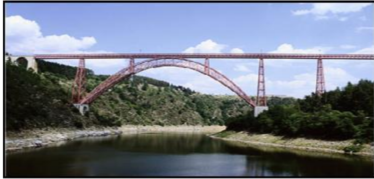
Fig. I.5. Pont arc en acier « viaduc de Garabit » construit en 1884.
