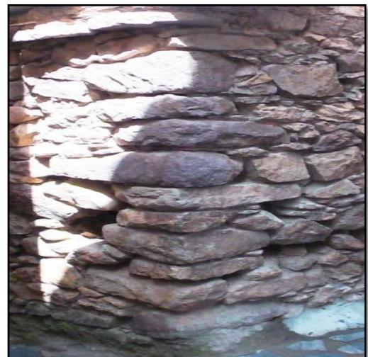
Figure 44 : système de rigidification des murs
