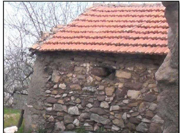
Figure43 : mur en pierres hourdées au mortier d'une maison
