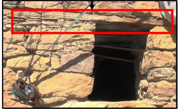
Figure 51 : linteau horizontal d'une fenêtre
