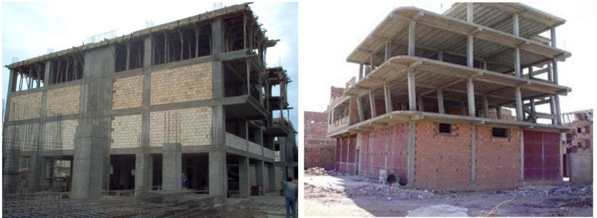
**Figure I-12.** Habitations collective & individuelle en Structure poteaux-poutres-voiles (Source : Auteur)
