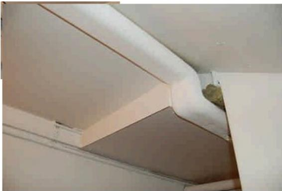
**Figure III-14.** Isolation sous dalle sous-sol. Caves, corridors, buanderie, local à vélos, chaufferie garages.
