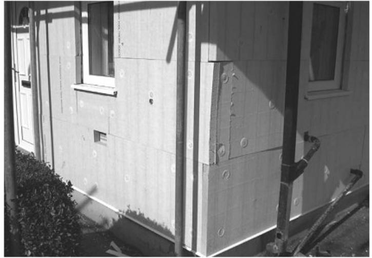
**Figure IV-8.** Isolation taillée autour d'une fenêtre et d'une ventilation et ajustée à l'angle du bâtiment.
