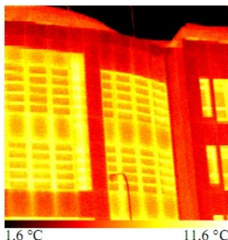
**Figure IV-1.** Thermographie de la façade d'un immeuble.
