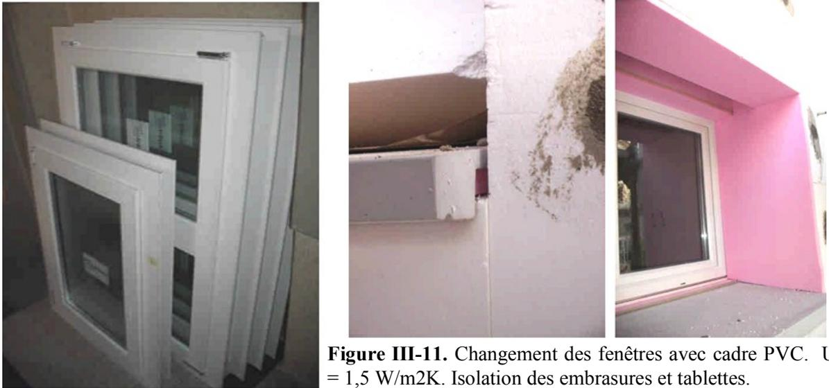
**Figure III-11.** Changeement des fenêtres avec cadre PVC.  $U_f = 1,5 \text{ W/m}^2\text{K}$ . Isolation des embrasures et tablettes.
