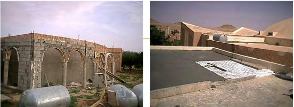
**Figure III-1.** Ombrage de la façade et isolation thermique de la terrasse
