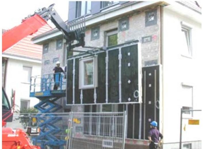
**Figure IV-11.** Pose d'un parement isolant lors de travaux de réhabilitation d'un immeuble à Hofheim en Allemagne.
