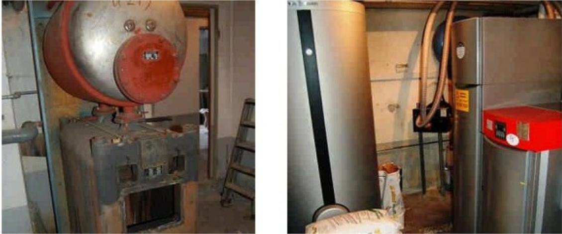
**Figure III-15.** Remplacement de la chaudière. (Rendement des équipements)
