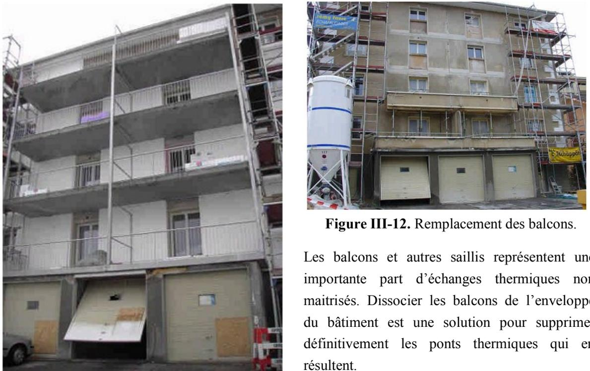
**Figure III-12.** Remplacement des balcons.
