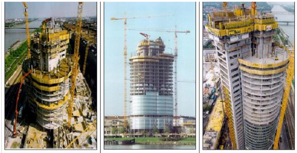
Fig. I-13 : Etapes de la construction de Millennium Tower (temps total de construction = 8 mois)
