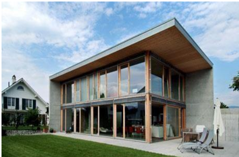
Figure II.4 : Maison en béton isolant.[12]
