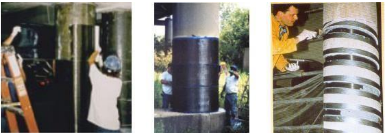
Figure III.10 : Stratification au contact (WBAC 2003). Une colonne peut être enveloppée complètement par des tissus «PRF » avec une ou plusieurs couches Figure III 10 (a). Elle peut être aussi partiellement enveloppée en utilisant des lanières «PRF » sous forme d'une spirale continue Figure III.10 (b) ou des anneaux discrets Figure. III. (c).[8]
