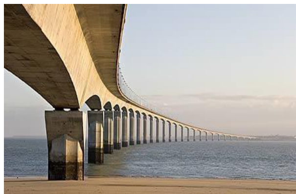
Figure I.3 : Le pont de l'Ile de Ré Rivedoux –Plage France.[2]
