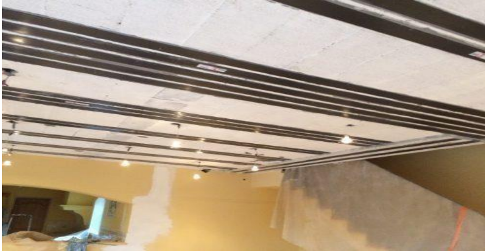
Figure III.16: Renforcement des dalles par la fibre de carbone [9].
