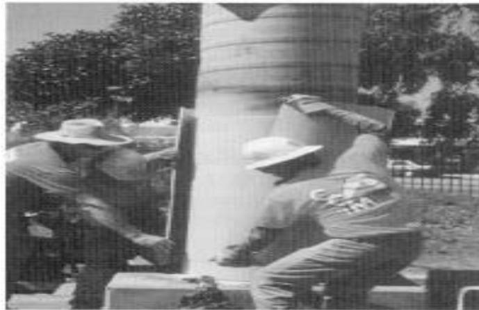
Figure III .13 : Chemisage par coquille préfabriquée en «PRF » ( Monti 2003 ) [8].
