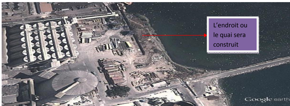
Fig. IV.1. Vue aérienne de l'endroit où le quai sera construit (source : Google earth).
