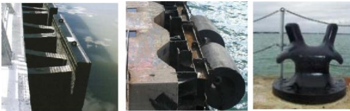
Fig. I.35. Équipements pour les ouvrages d'accostage et d'amarrage.
