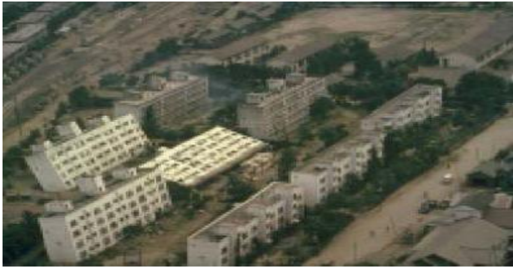
Fig. VI.5. Renversement d'immeubles suite à la liquéfaction du sol lors du séisme de Niigata en 1964.
