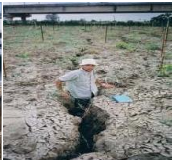
Fissure du terrain
