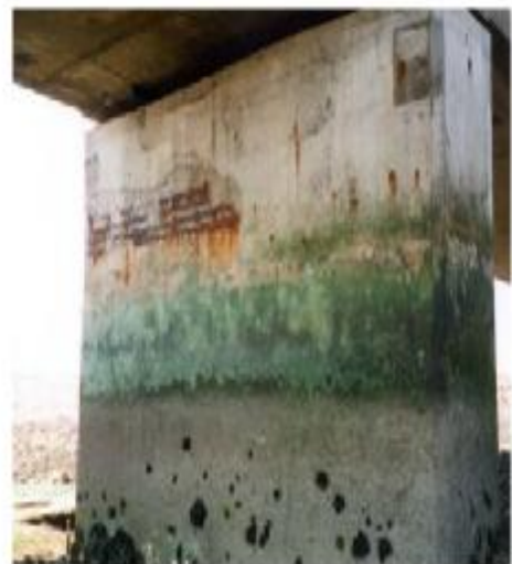
Fig. I.37. Pile en zone de marnage.
