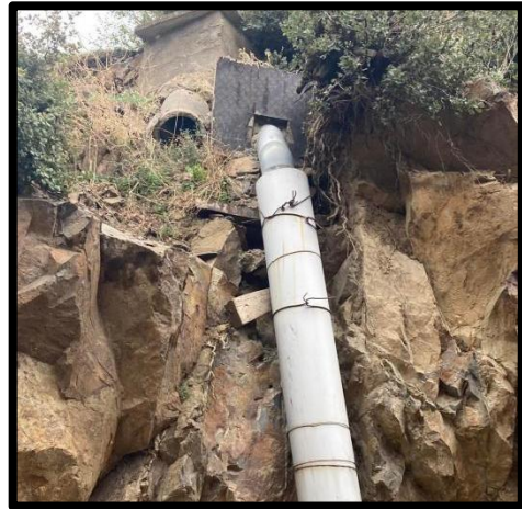
Image 46: ancienne canalisation / source : auteur
