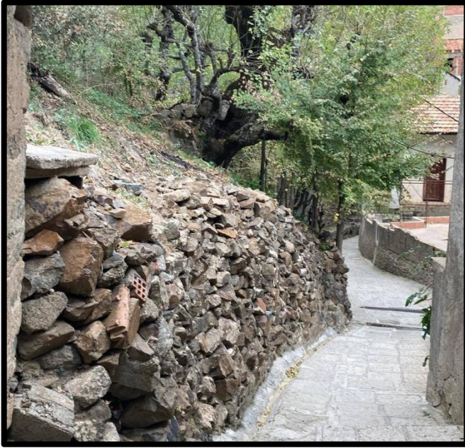
Image 51 : ruelle du village / source : auteur
