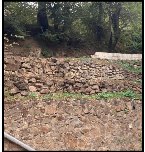
Image 52 : mur en pierre / source : auteur
