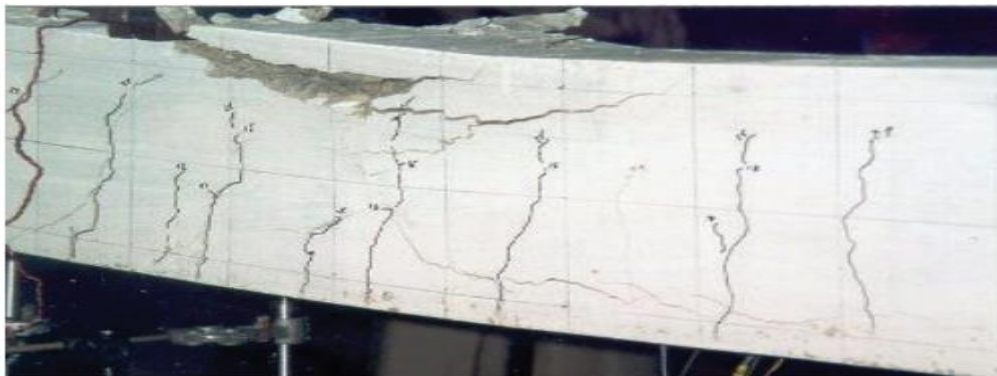
Figure.I.2 : Rupture en flexion de la poutre [23].
