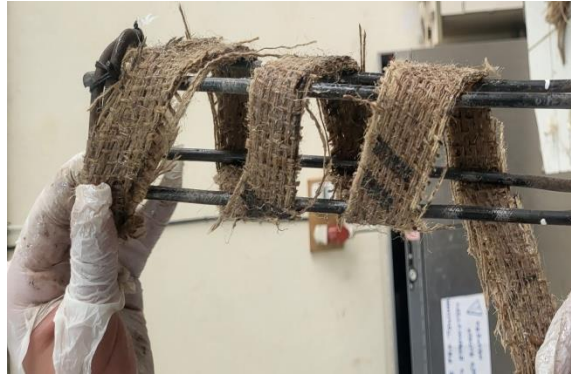
Figure II.8 : Mise en place du renfort
