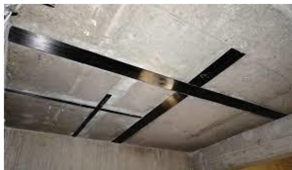
Figure I.7 : Renforcement à l'aide de tôles collées [7]
