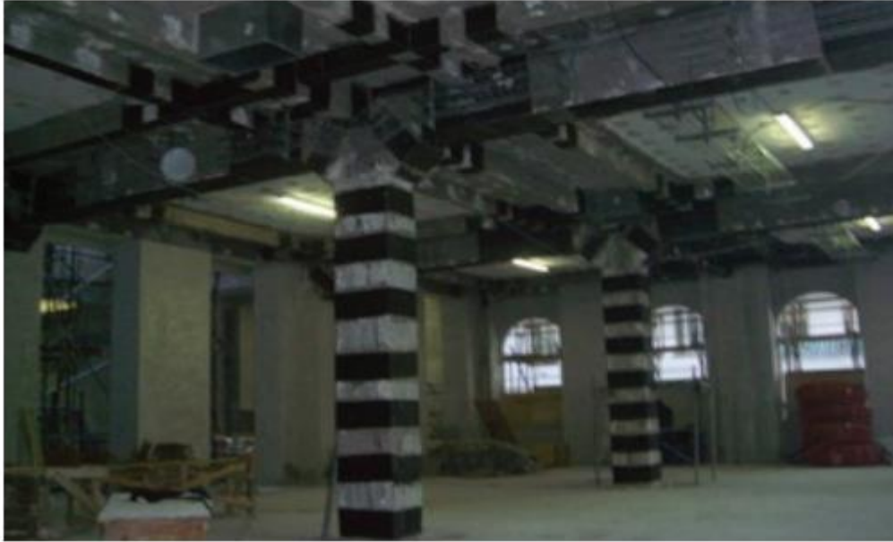
Figure I.1 : Renforcement de structures BA par matériaux composites [22]
