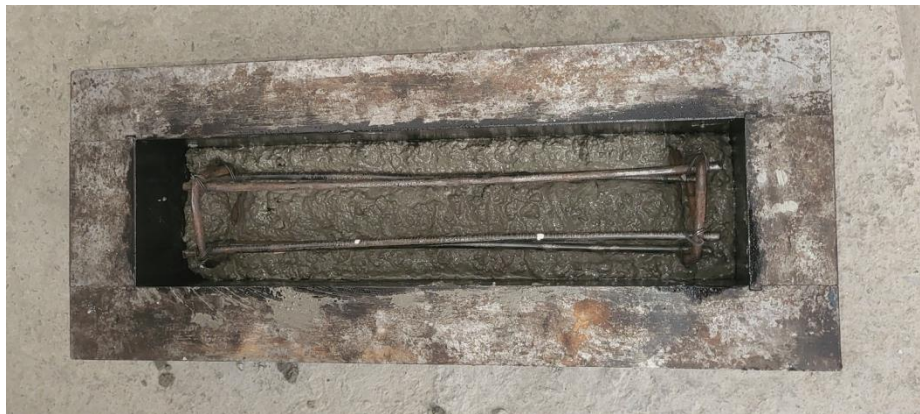
Figure II.11 : Coulage des poutres.
