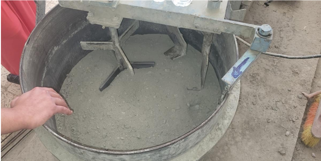
Figure II.10 : malaxage du béton
