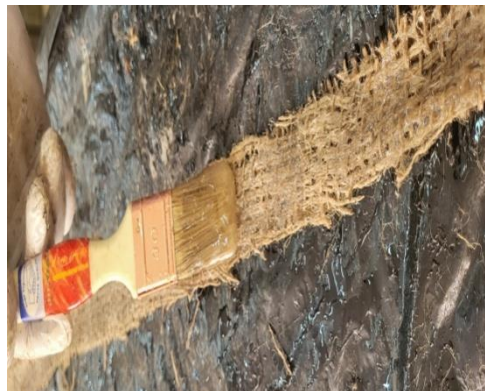
Figure II.9 : Application de la résine sur les bandes de jute.
