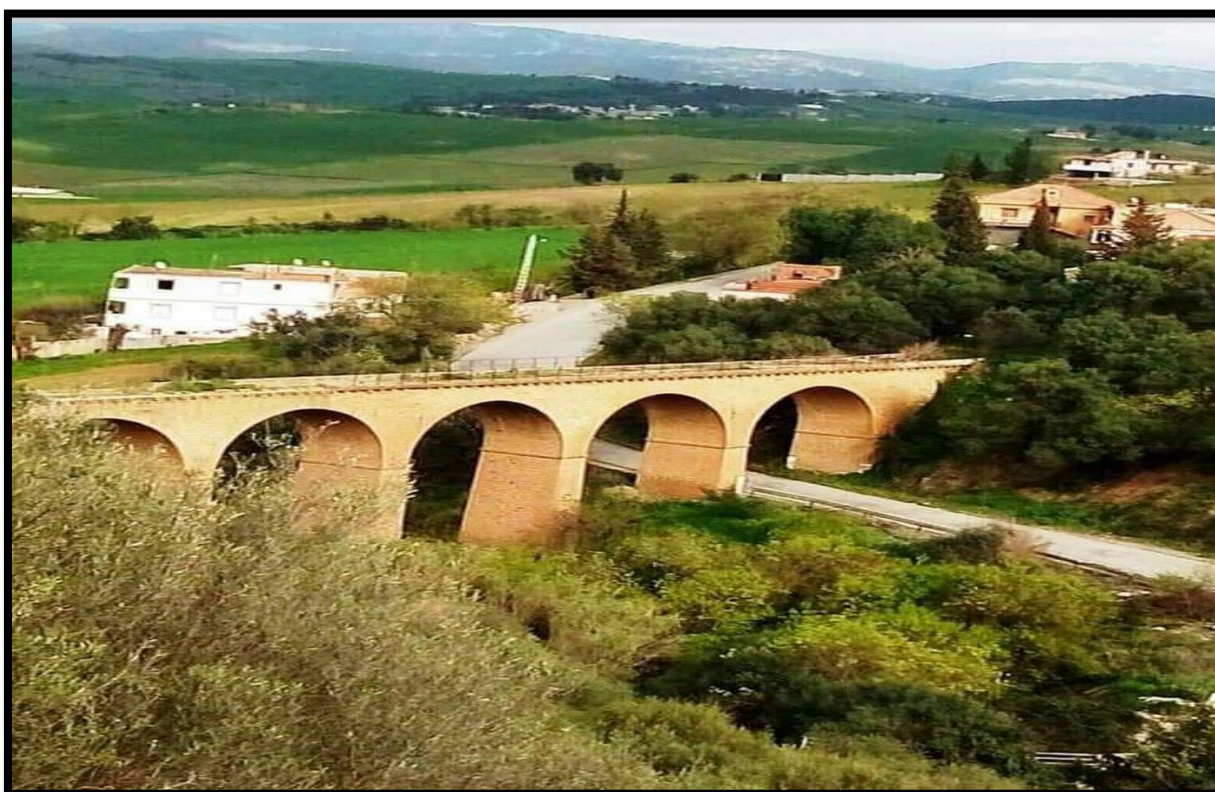
Photo N 6 : Le pont des 07portes situé sur la route Dra El Mizan-Frikat
