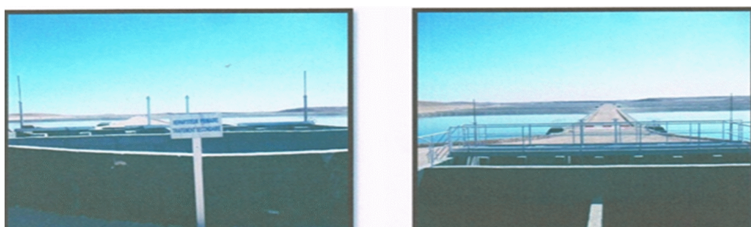
Figure 5 : Répartiteur principaux vers les bassins primaires et secondaires, (DHW, 2013)
