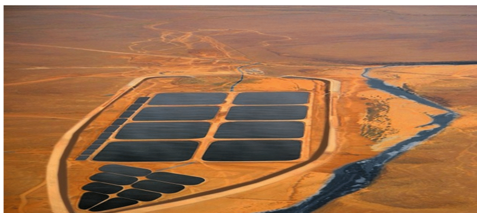
Figure 2 : Vue aérienne de la STEP d'EL-ATTEUF (DHW, 2013).
