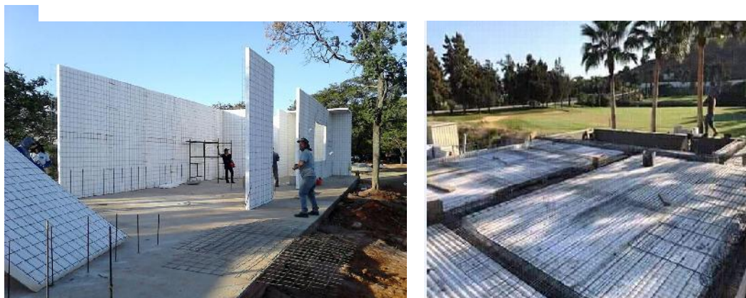
Figure 2-3 : Plancher bas du garage
