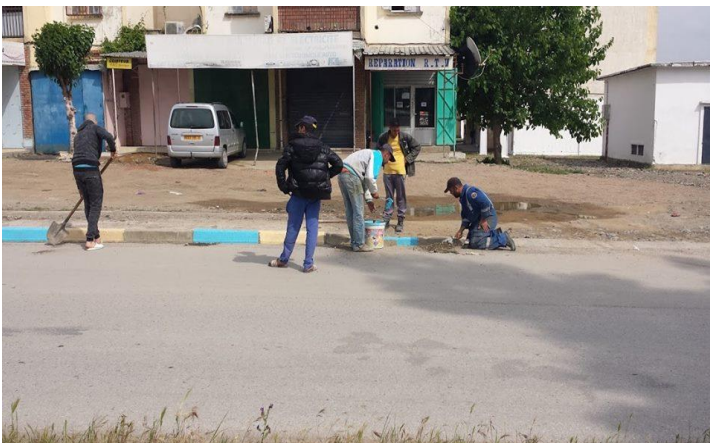
Figure 36: travaux de peinture sur les bordure des trottoirs
