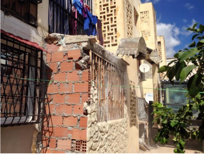
Figure 26: démolition des extensions illicites
