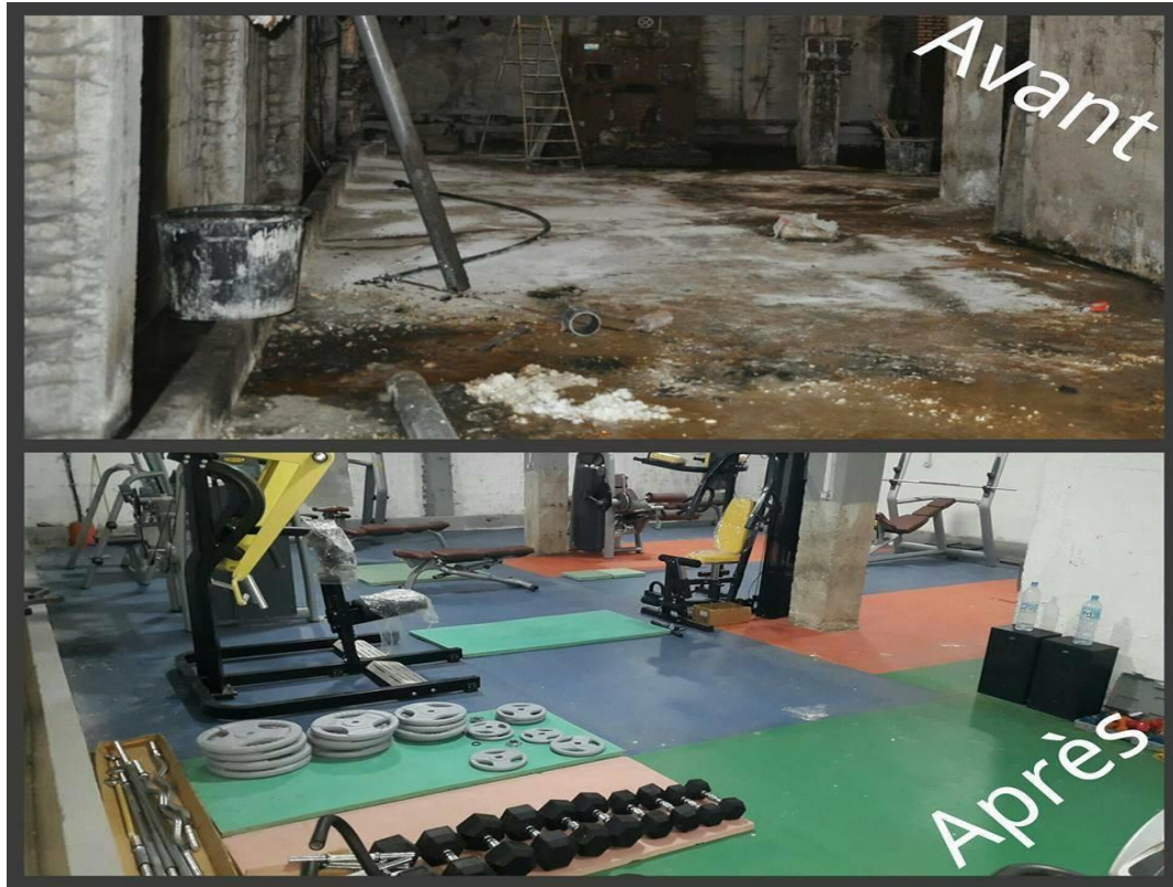
Figure 23: la salle de sport avant et après travaux
