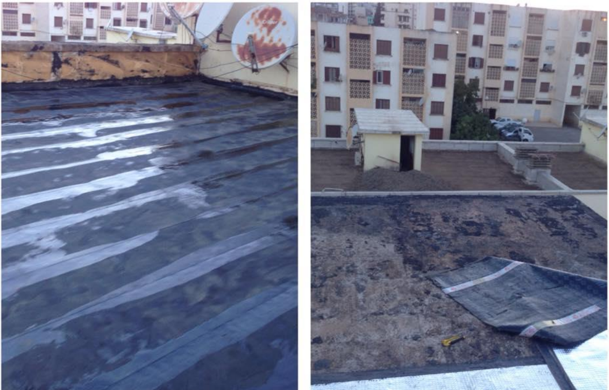
Figure 21: travaux d'étanchéité sur les terrasses( source: facebook de l'association)
