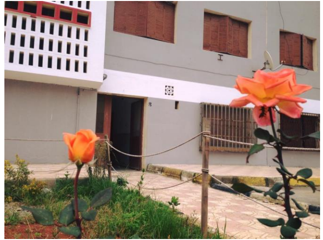
Figure 25: vue actuelle après intervention
