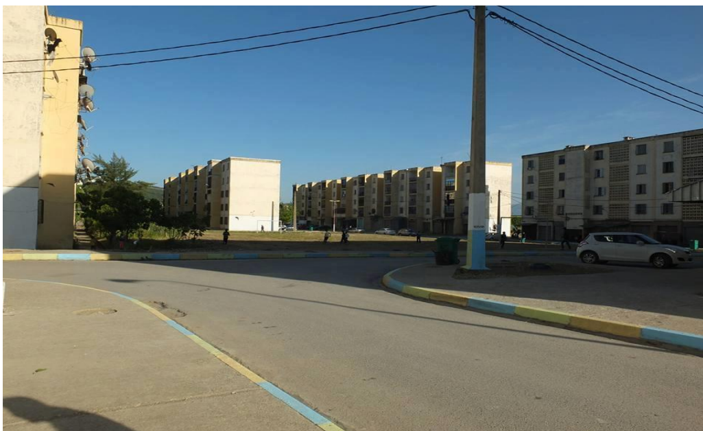
Figure 41: vue d'ensemble après intervention
