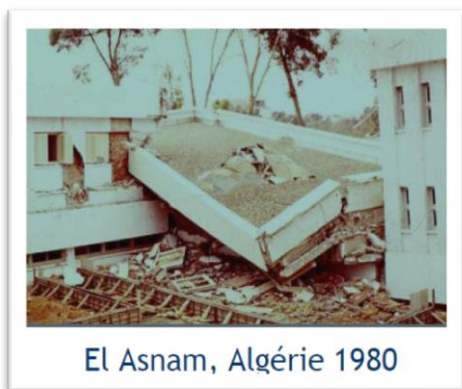
Figure (I.6) : effondrement dû aux oscillations asynchrones
