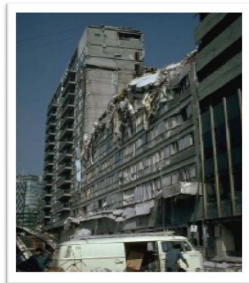
Figure (I.10) : destruction des immeubles sous l'effet de la résonance du bâtiment avec le sol.
