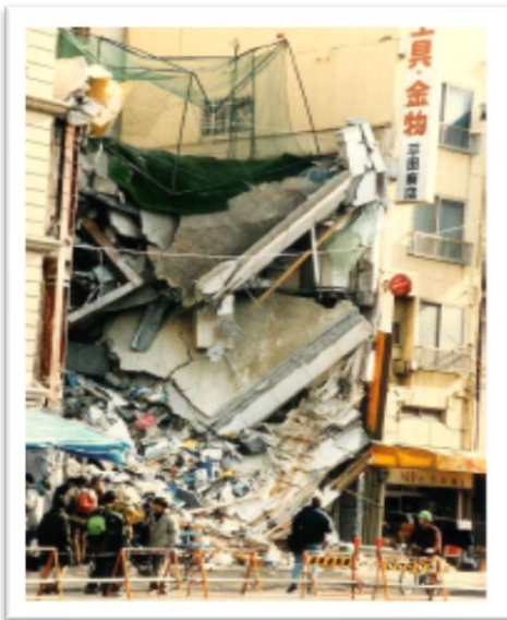
Figure (I.10) : destruction des immeubles sous l'effet de la résonance du bâtiment avec le sol.
