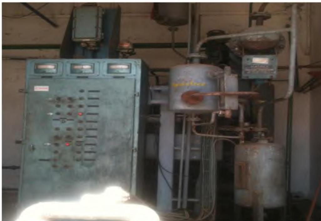
Figure 12 : L'appareil de régénération de type MATREP
