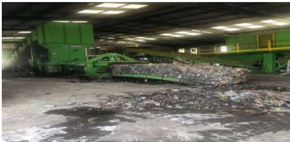
Figure6 : Centre de tri des des dechets du CET
