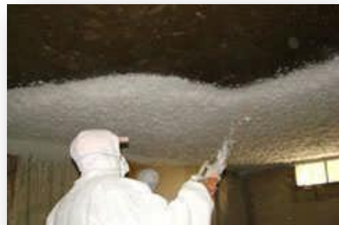
Figure 20 : projection de l'isolant sur les éléments de la structure.
