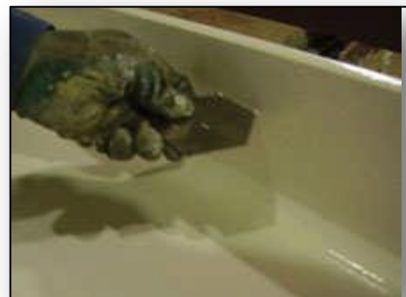
Figure 19 : peinture des éléments de la structure.
