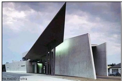
Figure13 : Caserne de pompiers de l'entreprise Vitra, Allemagne. Source : encyclopédie encarta 2009
