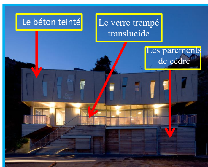
Photo 67: les matériaux de construction Source : site web https://www.pleneuf-val-andre.fr/activites/centre-nautique/
