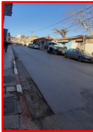
Photo 24: la RN 24 Source : auteur le 03/11/2022
