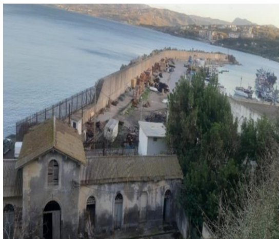
Photo 59: bâti en état très dégradée existant au niveau du port
