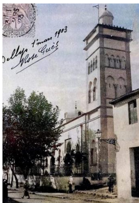
Photo 2: vue sur la grande mosquée de Dellys Source : archive de Dellys
