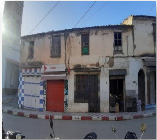
Photo 26: bâtisse à usage mixte (résidence + commerce) Source : auteur le 03/11/2022
