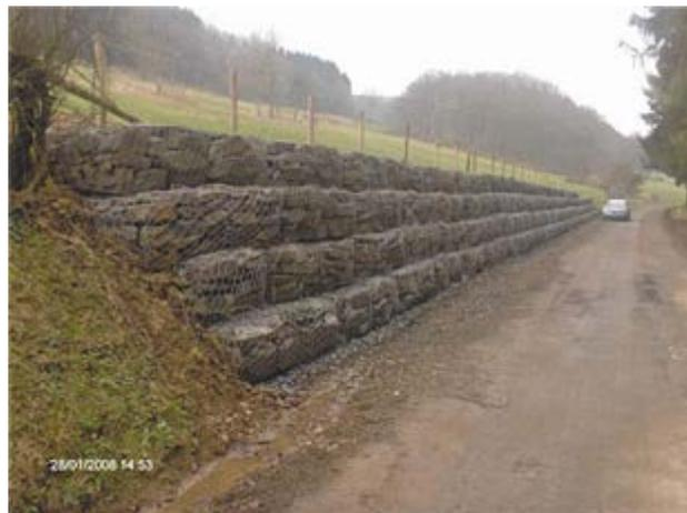
**Photo III.3 Photo de Mur formé de gabions.**
