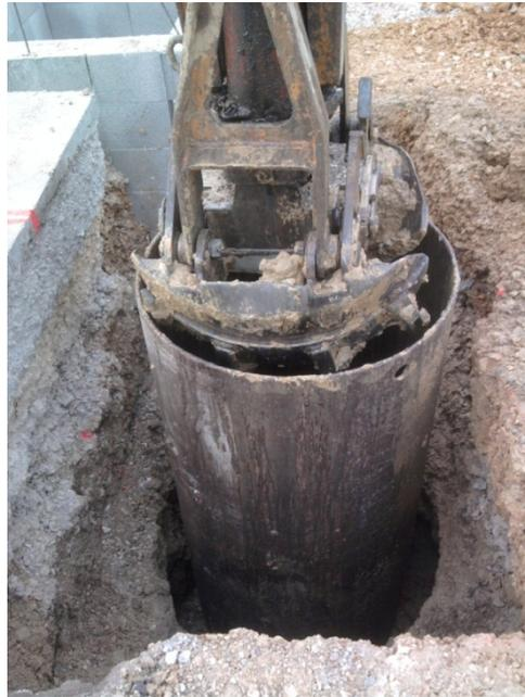
**Photo IV.6 Pieux forés à l'abri d'un tube de travail récupéré.**
