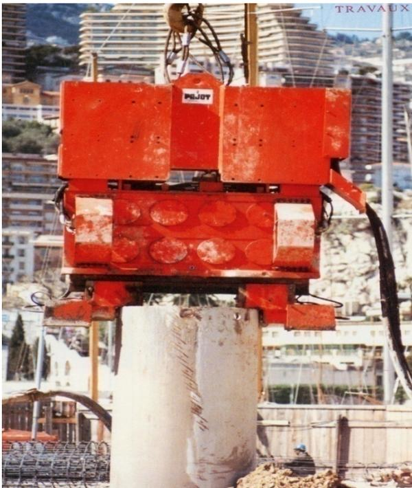
**Photo IV.12** Procédure de vibro-fonçage d'un pieu foré tubé.
