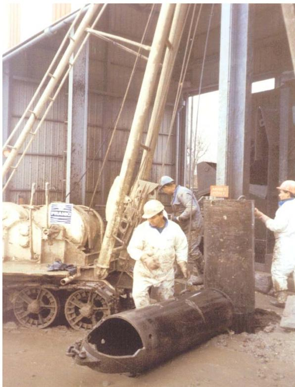
**Photo III.15.** Réalisation d'un pieu foré de petit diamètre.
