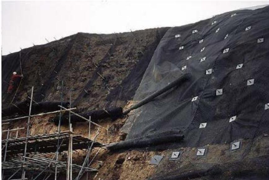
**Photo III.4 Un versant stabilisé par clouage.**
