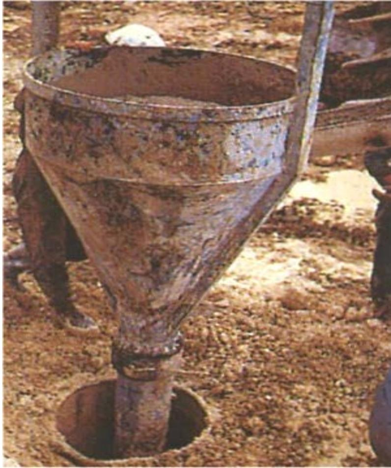
**Photo IV.10 Tube plongeur de coulage du béton.**
