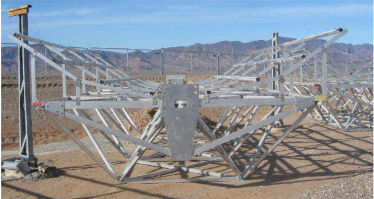
**Figure III.14** : structure métallique d'un capteur cylindro-parabolique [24].
