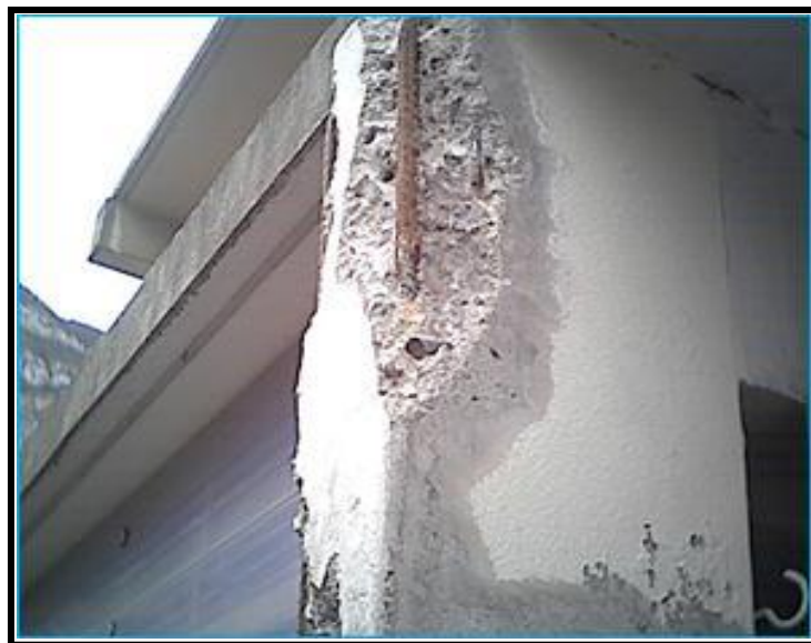
Figure I.1-2 : Dégradation des éléments d'un ouvrage par carbonatation
