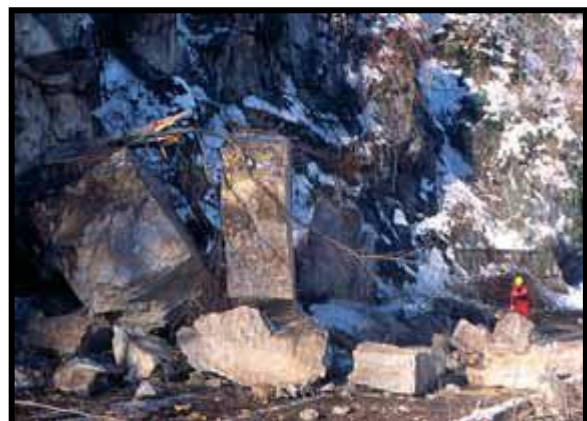
Figure I.1-11 : Eboulement sur la RN85 à l'entrée du village de Laffrey (Isère).janvier
