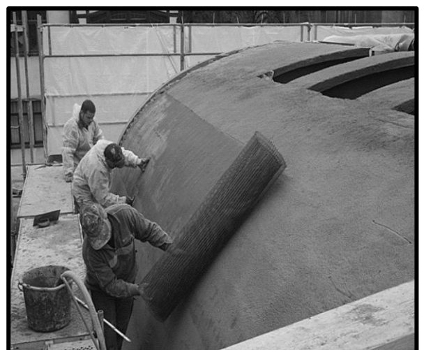
Figure-I.2-16: la Rénovation d'un toit en forme de tonneau à Zwickau (Allemagne)
