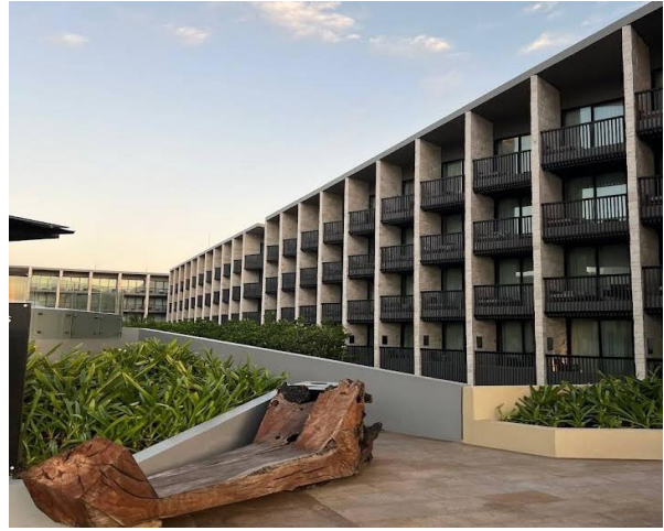
Figure 81 : une vue sur les chambres de l'intérieur La source : www.archdaily.com
