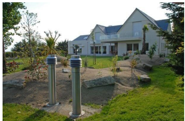
Figure 8: puits canadiens La source : https://www.climamaison.com/lexique/puits-canadien.htm
