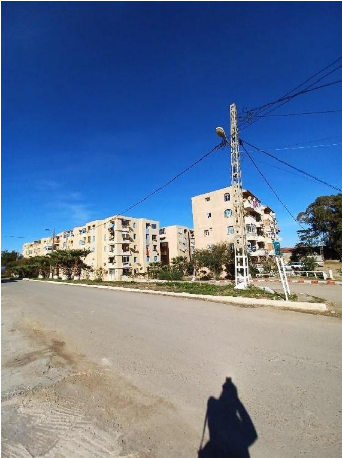
Figure 59 : vue sur la voie secondaire Source : visite sur le site e 17-12-23
