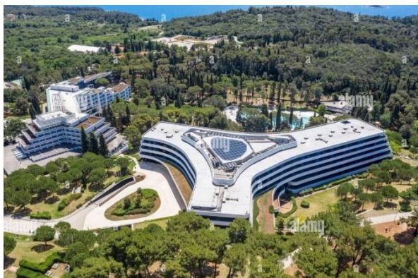
Figure 87 : vue aérienne de l'hôtel La source : http://www.archiscene.net
