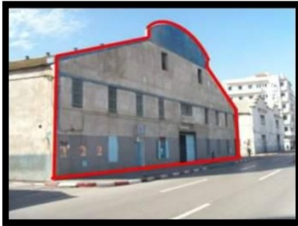
Figure 74 : Hangar , source: auteur
