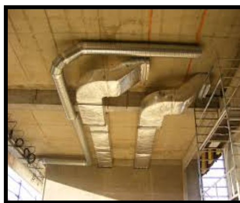
Figure 193 : les gaines fixés au faux plafonds
