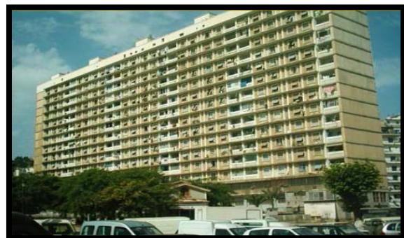
Figure 69 : Bâtiment type H.B.M
