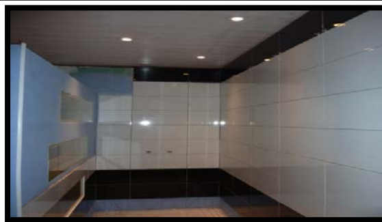
Figure184 : mur avec revêtement en faïence
