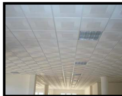
Figure 186: faux plafond en plaque de plâtre
