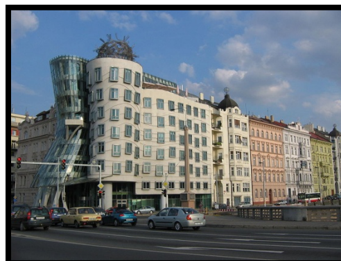
Figure 125: vue de l'immeuble Nationale-Nederlanden .
