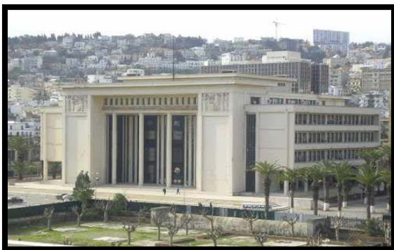
Figure 68 : Bâtiment type Moderne - Siège UGTA
