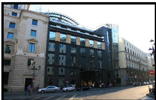
Figure 103: Façade nord de l'hôtel Urban
