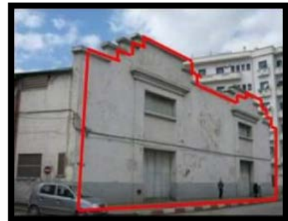
Figure 75 :Hangar, source: auteur
