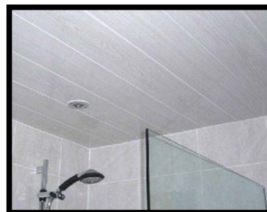
Figure 187: faux plafond en PVC
