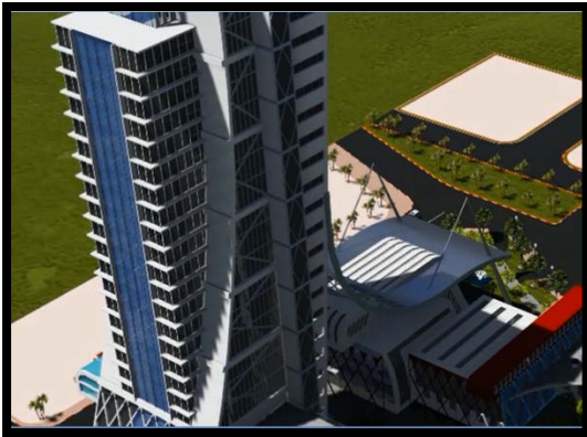
Figure 161: la façade inclinée de la tour
