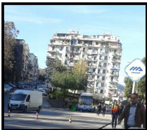
Figure 141 : L'habitat collectif de la rue Belouezdad (style néo-classique).
