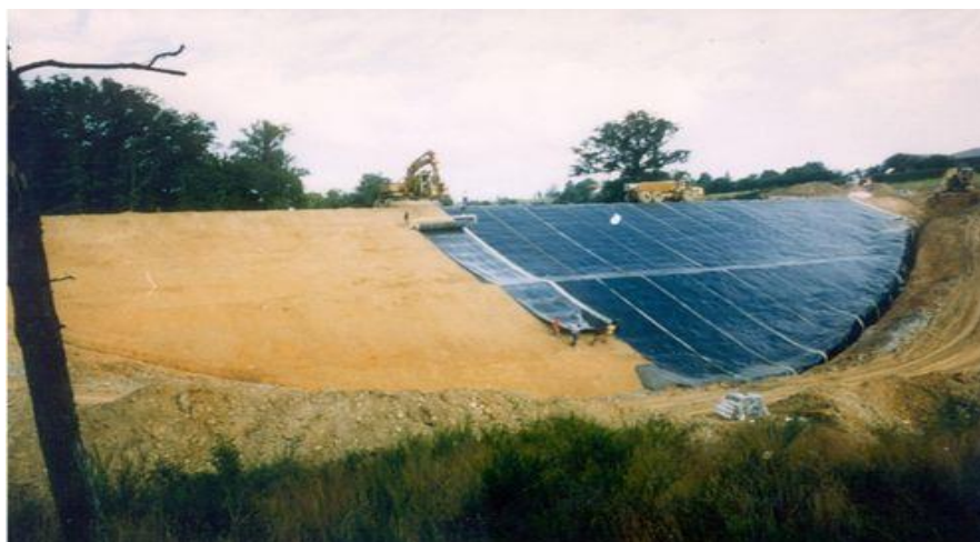
Figure I.7 Pose d'une géomembrane (photo Irstea Bordeaux)
