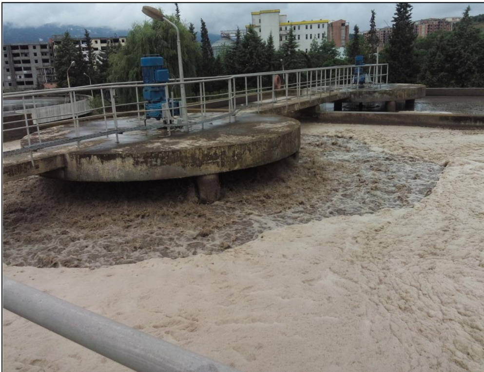
Figure 4. Image du bassin d'aération de la station d'épuration des eaux usées de Tizi Ouzou.
