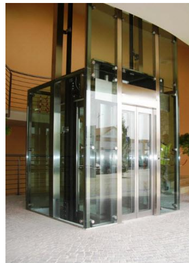
Figure. 101 : Ascenseur panoramique, Source : http://www.ascensorisulweb.it/
