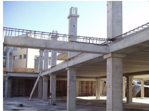
Figure. 91 : Structure poteaux poutres, Source : https://www.archiproducts.com/
