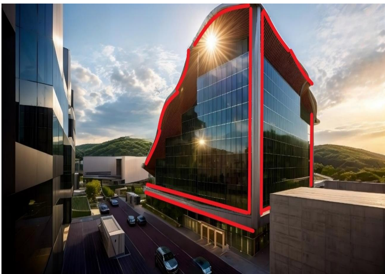
Figure. 83 : Façade latérale (Rue Lamali Ahmed), Source : Auteurs.
