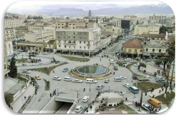
Figure 21 : Nœud Babouche said, Source : Google maps
