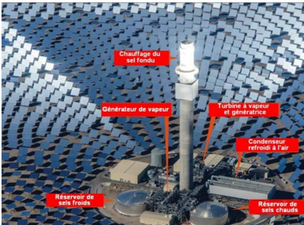
Figure IV.4 : Photographie du cœur de l'installation de Crescent Dunes
