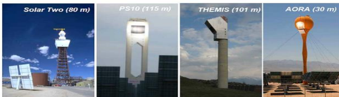
Figure III.6 : différentes architectures des tours solaires [31]
