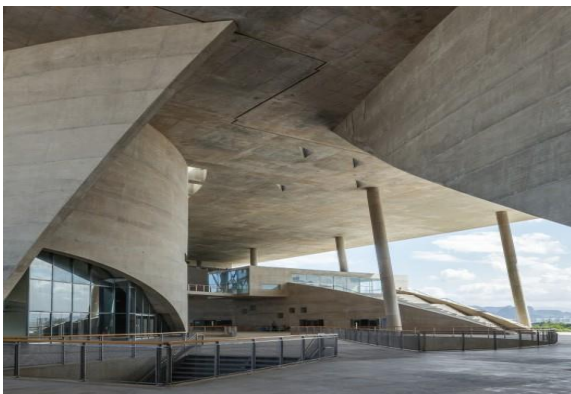
Figure 31 : Utilisation du béton.
