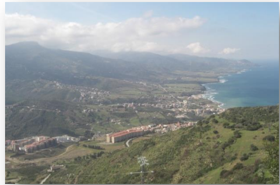
Figure 1 : vue sur Azeffoun. Source : https://www.google.com/img .
