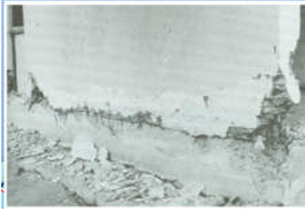
Fig I : rupture par glissement à la base. [31]
