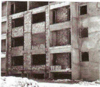
c) El Asnam : excellent comportement du bâtiment avec voile en béton armé
