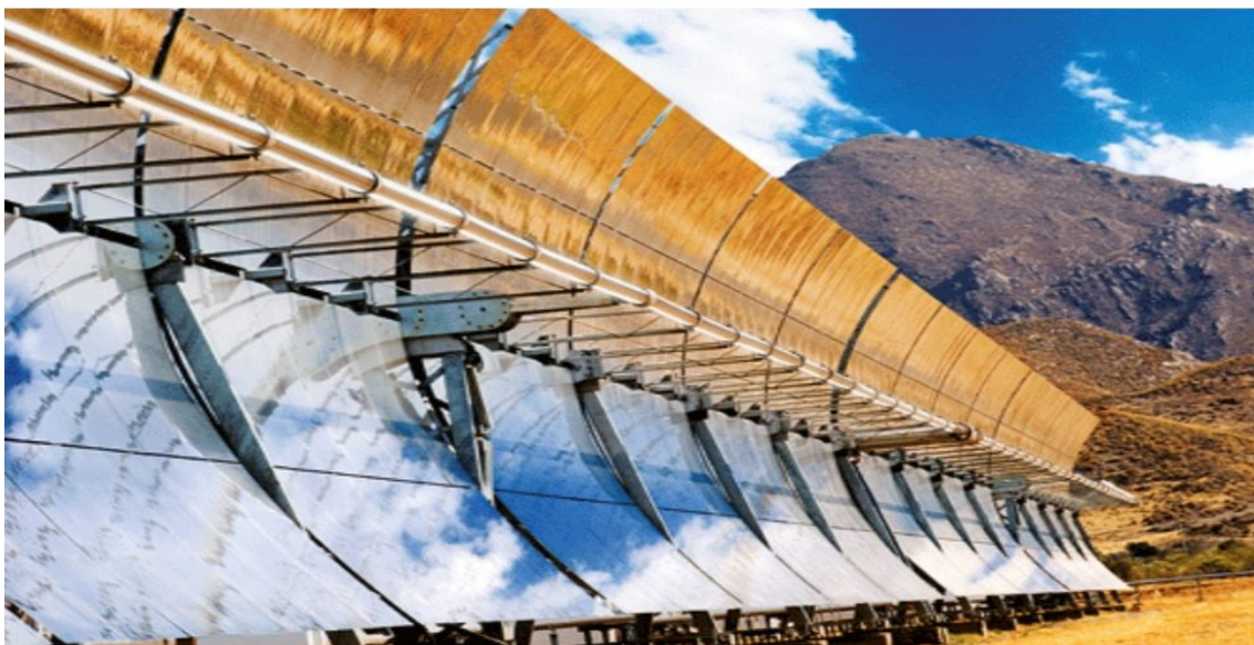
Figure II.7 : Concentrateur cylindro-parabolique
