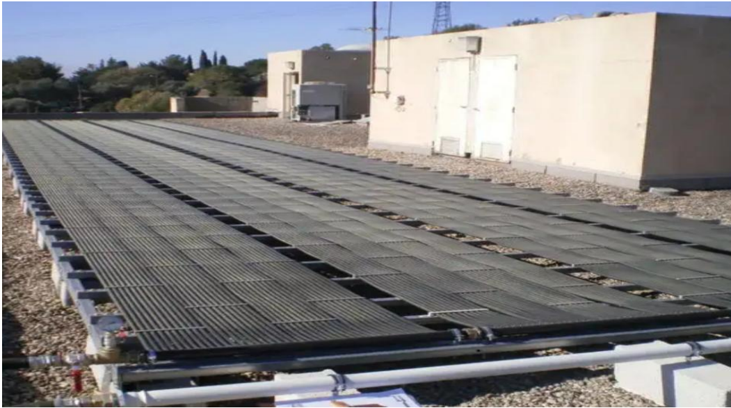
Figure II.3 : capteur solaire non vitré
