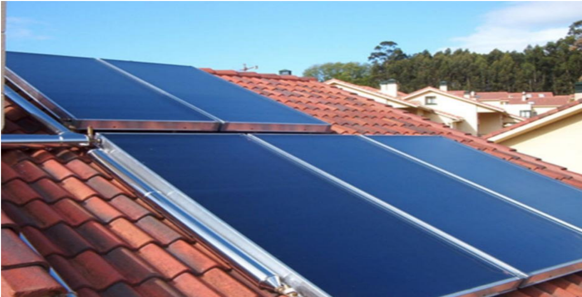
Figure II. 4 : capteur solaire plan vitré
