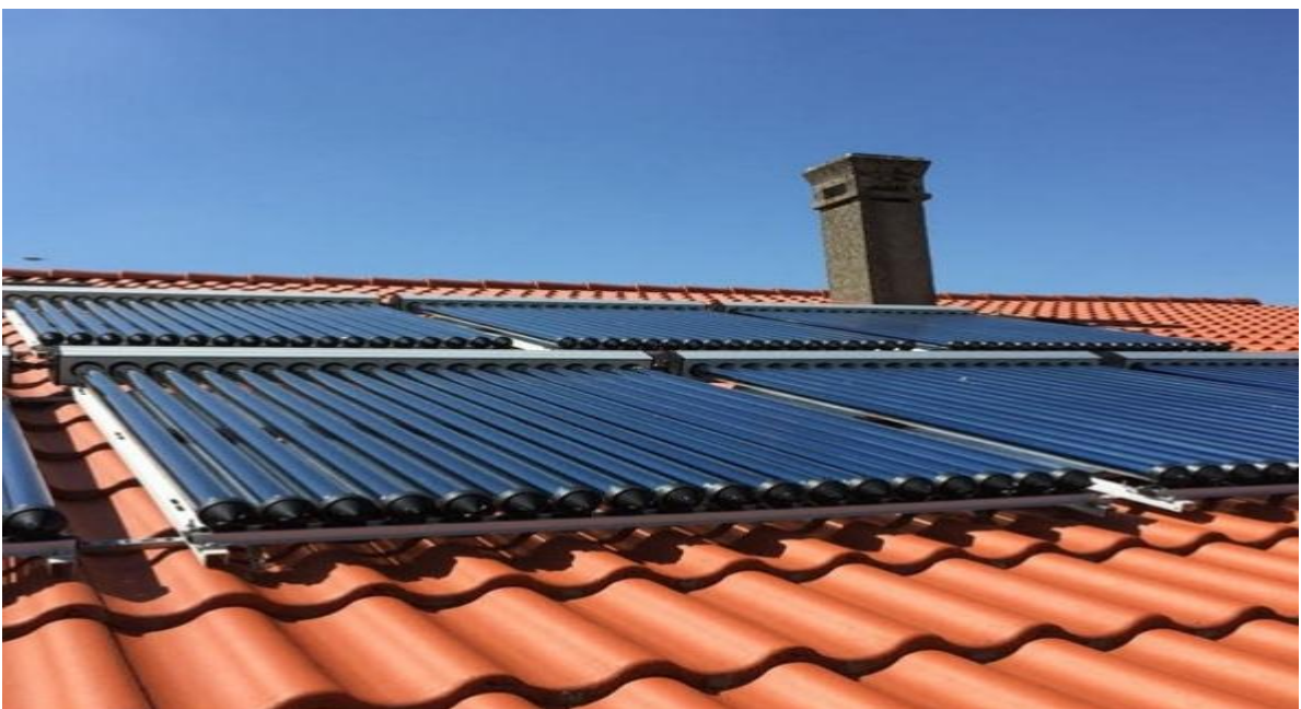
Figure II.5 : capteur solaire sous-vide
