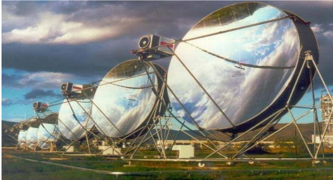
Figure II.8 : Concentrateur parabolique
