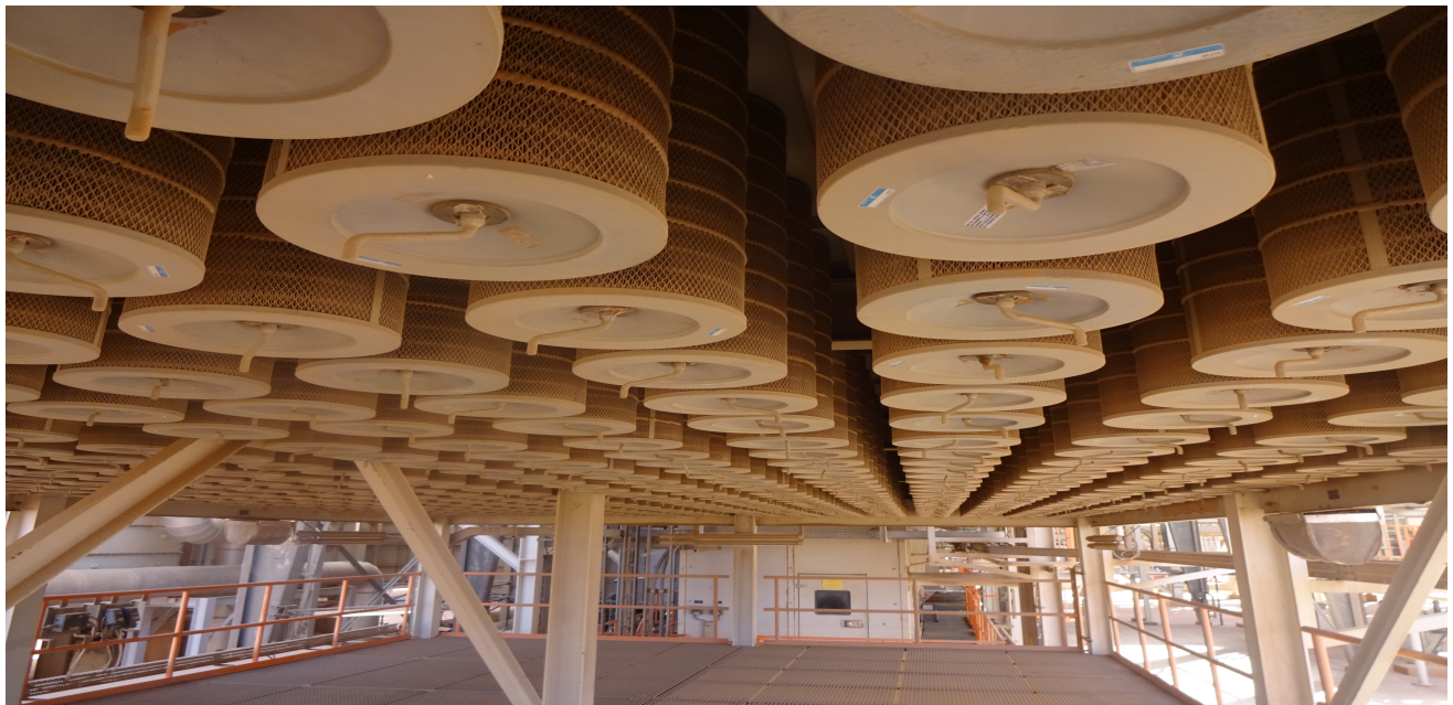
FIGURE 3.3 – Disposition des éléments filtrants du système auto-nettoyant à flux vertical.
