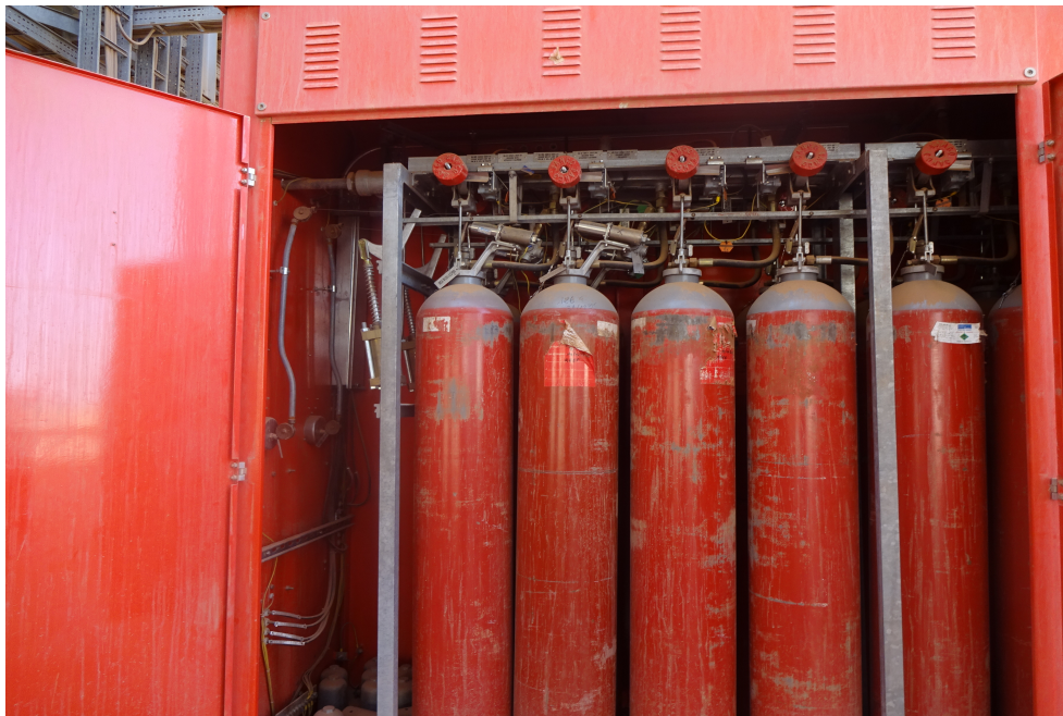
FIGURE 2.7 – Système de protection CO 2
