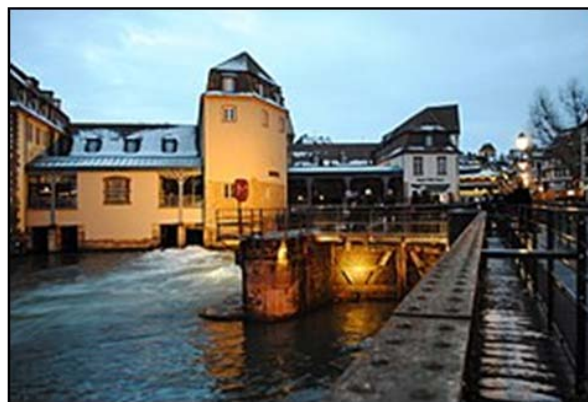
photo 1 : Vue de la passerelle de l'écluse de la Petite France Source : Google photos
