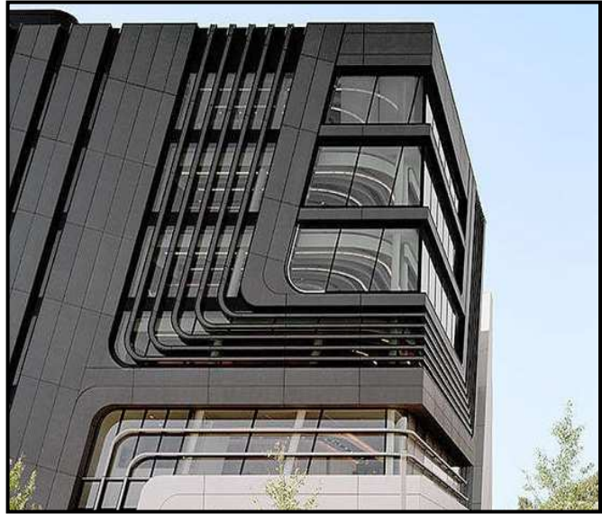
Photo III-7 : Exemple façades en béton fibré Source : trends.archiexpo.fr
