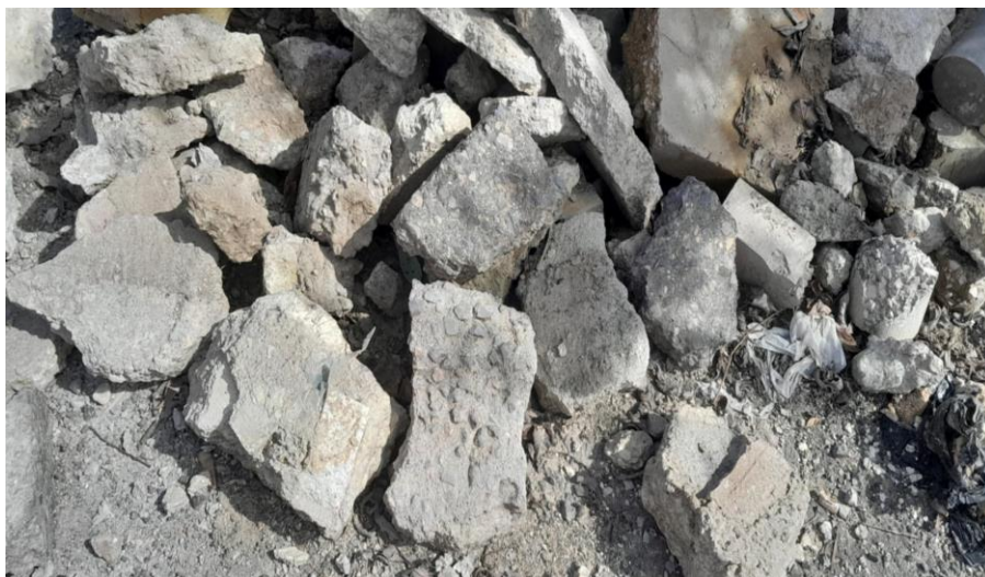
Figure II.5 : déchets de démolition des vieux murs.
