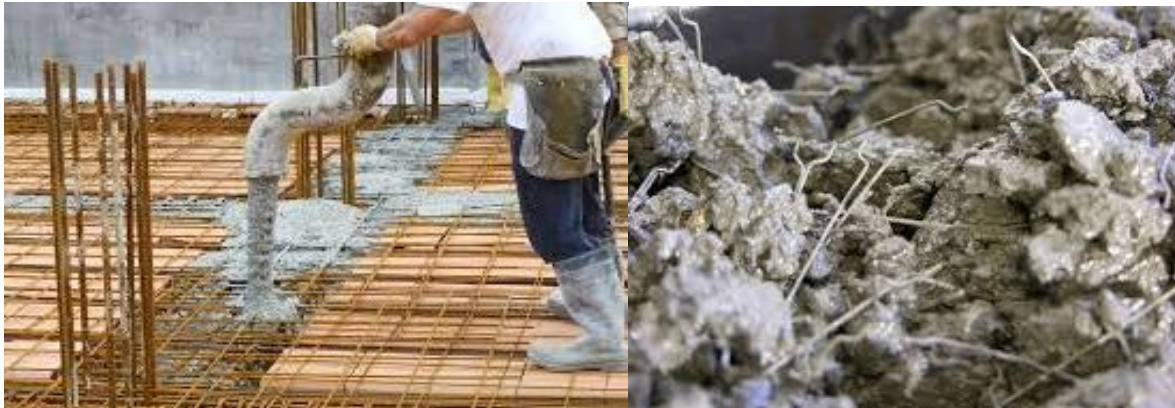
Figure.II.4 Plancher en béton fibré [35]
