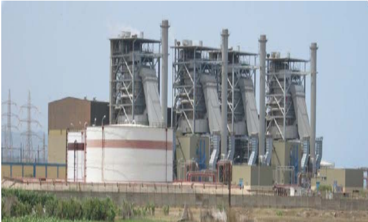
Figure I.2 : Centrale thermique de CAP-DJINET.
