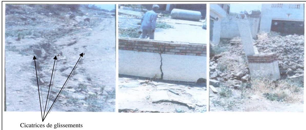
Figure 3.28. Traces de glissement sur le sol, fissures et dislocation de mur de clôture (Photos extraites de l'étude géotechnique réalisée par LNHC, 2002).
