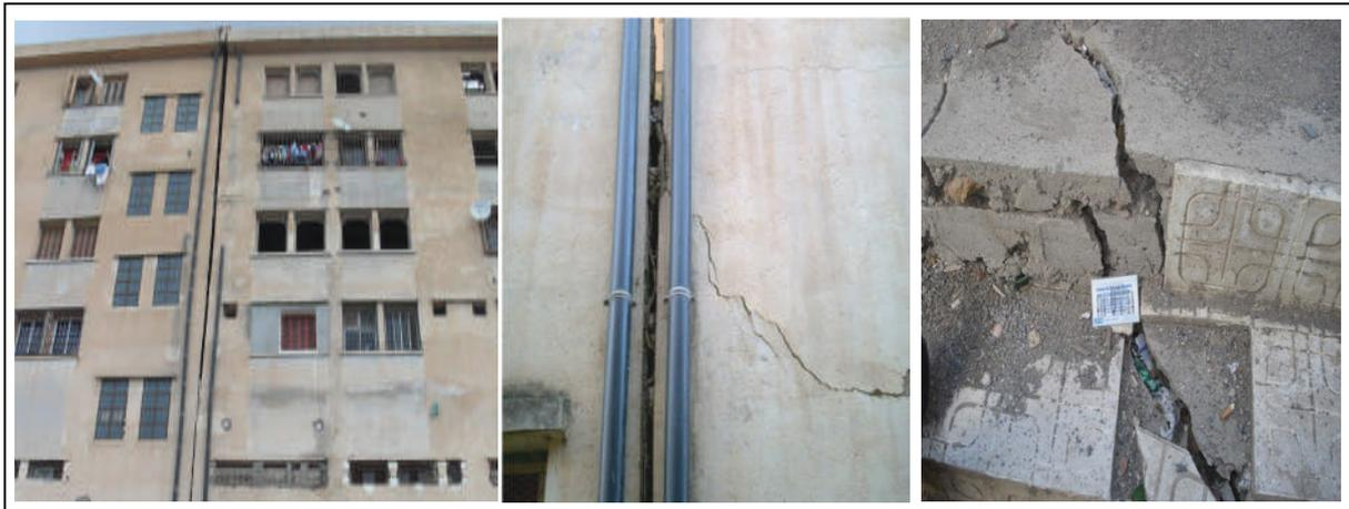
Figure 3.5. Écartement prononcé de joints, fissures apparentes sur murs et dégradations des dallages.
