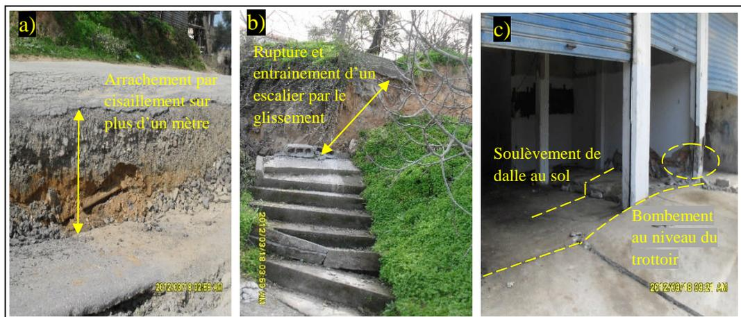
*Figure 2.12. dommages engendrés par les glissements d'Azazga.*
