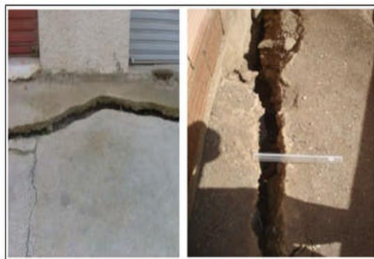
Figure 5.26. Fissures de traction à proximité d'une construction individuelle.
