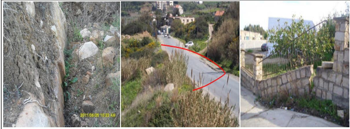
*Figure 3.30. Large escarpement sur le versant côtier et affaissement de routes.*
