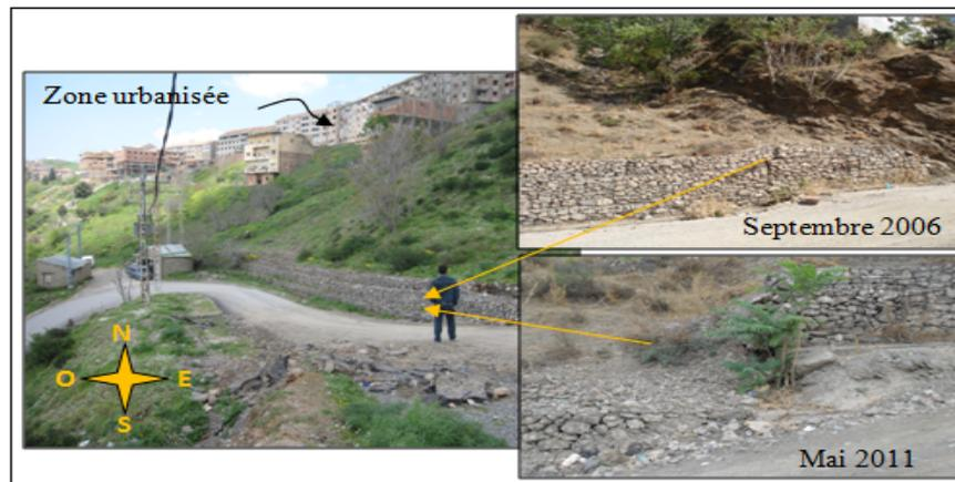
Figure 3.12. Propagation et évolution du glissement vers l'aval du versant.
