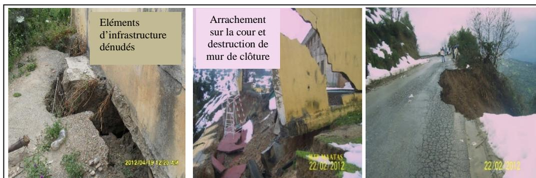
*Figure 2.16. Importants désordres dans des établissements scolaires à Maatkas (Ecole primaire à gauche et CEM au centre) et arrachement partiel au niveau du CW 147 (photo à droite).*
