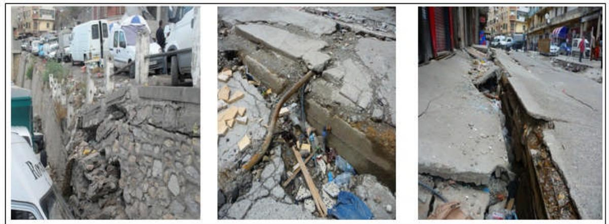
*Figure 3.14. Dislocation de mur de soutènement, affaissement de trottoirs et fissures dans les chaussées affectant les réseaux de conduites.*
