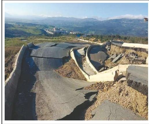
*Figure 2.13. Reactivation du glissements d'Azazga en 2018.*
