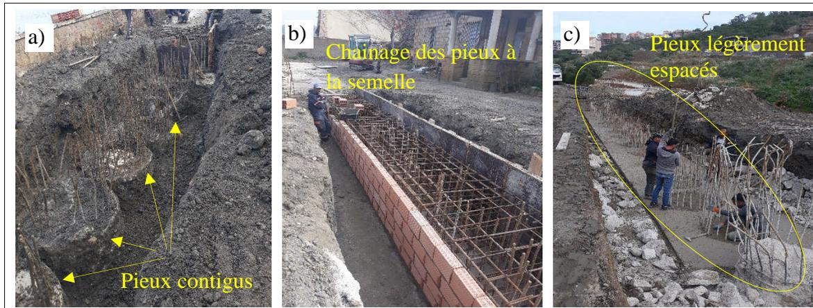
Figure 3.31. Réalisation du système de stabilisation : a) et b) secteur central à la périphérie nord de la subdivision d'hydraulique, b) secteur Ouest.
