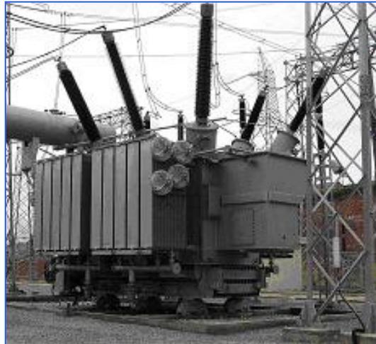
Figure I-25. Transformateur de puissance
