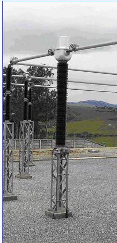
Figure I-17. Transformateur de courant
