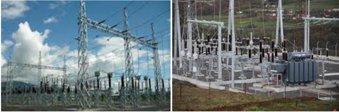
Figure II.3 : Poste classique extérieur.
