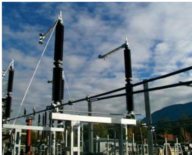
Figure IV.3 : Sectionneur à 2 colonnes tournantes à coupure centrale.
