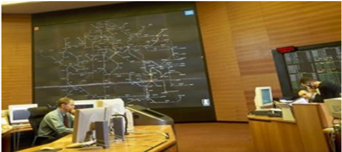
Figure I-8 : Centre de contrôle dispatching.
