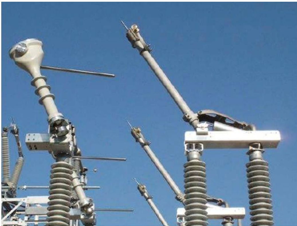
Figure IV.2 : Sectionneur de type extérieure.
