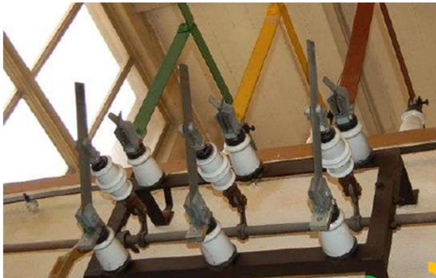
Figure IV. 1:sectionneur de type verticale.
