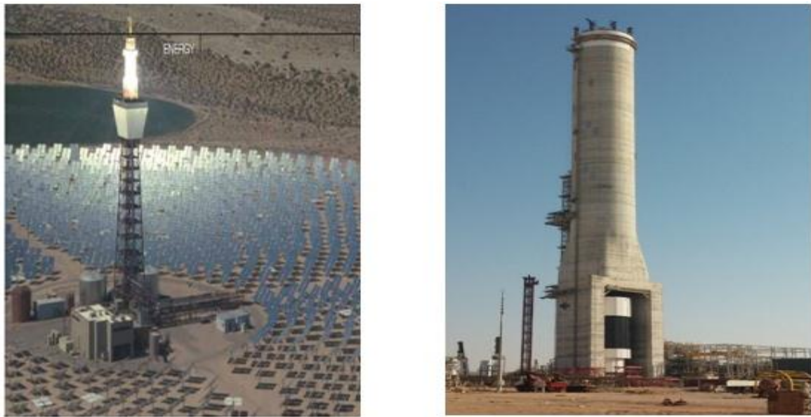
Figure II 8 : Une tour métallique et une tour en béton.
