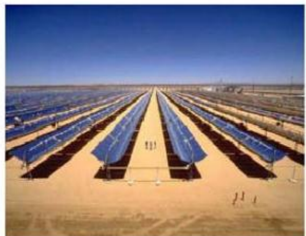
Figure I 29 : Centrale cylindro-parabolique [26].
