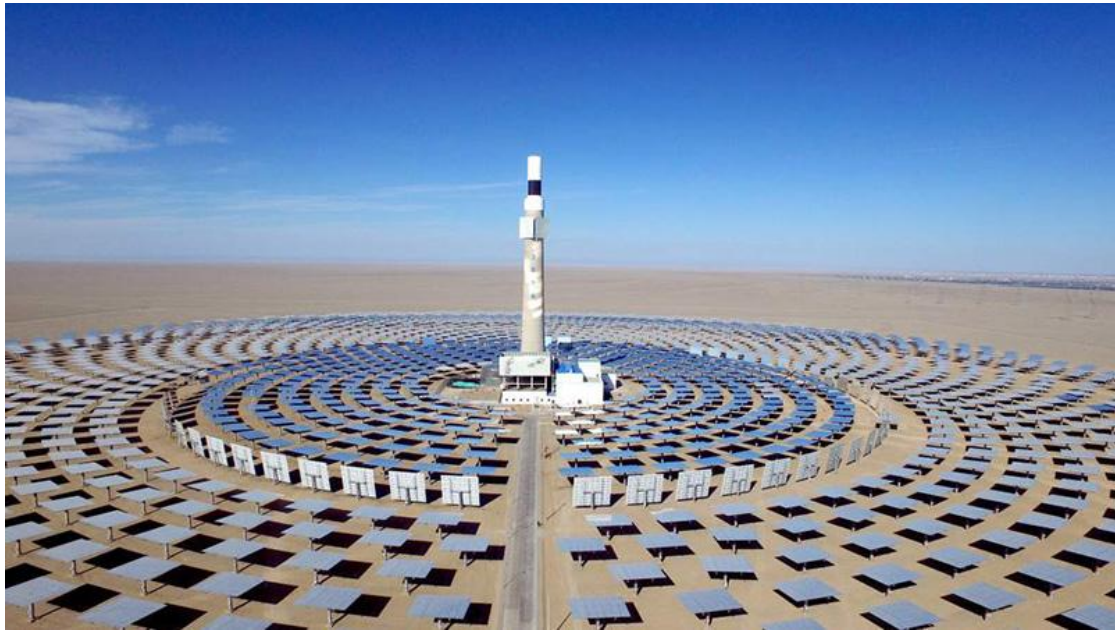
Figure II 1 : Centrale solaire à tour.
