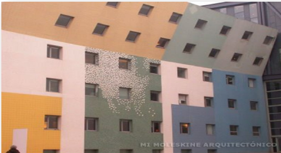
Fig.63. Façade de la cité de musique
