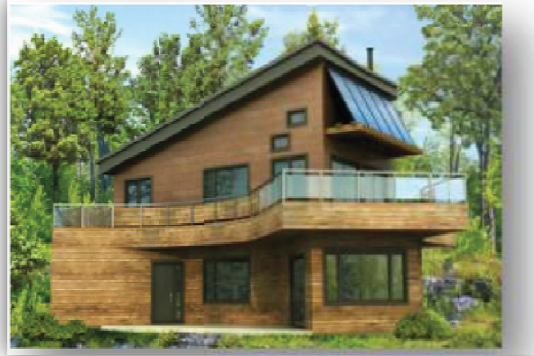
Fig.20. Eco-Villas des Coteaux du lac à Oxford, au Québec
