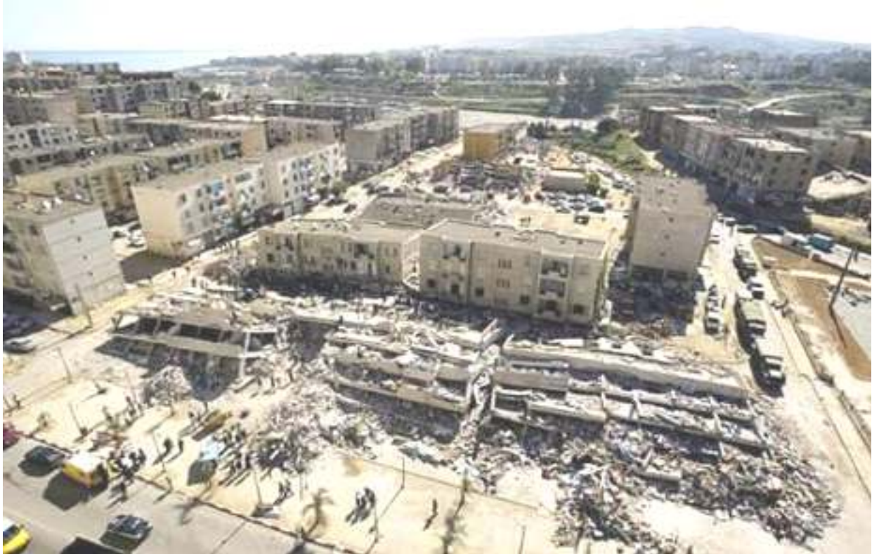
Figure 5: Ampleur des dommages subis par les bâtiments (Zemmouri, 21 Mai 2003)
