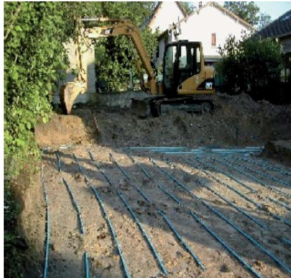
Fig .I.9.Pose de capteur horizontal après décapage du terrain
