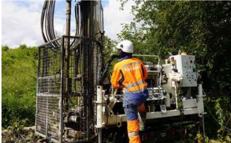
Figure IV.3. Photo d'un le forage par carottage(fondasol, mars 2015).
