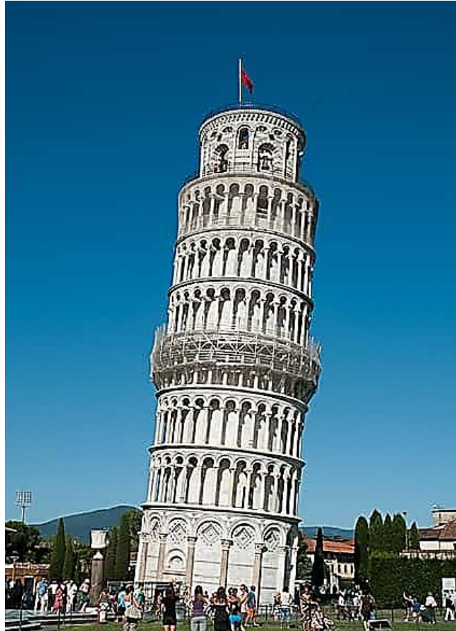
Figure.V.5. inclinaison célèbre de la tour de pise due à un affaissement du terrain marneux (Donato, 23 decembre 2010).
