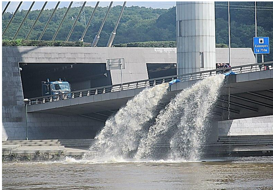
Figure.V.12. Un tunnel inondés à Kinkempois(hartia, 21 juillet 2021).
