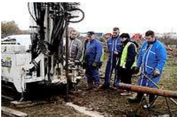
Figure IV.1. photo d'un forage destructif (cerema, 6 août 2015).
