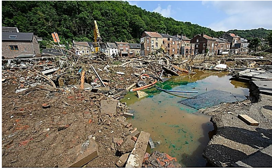
Figure.V.12. Dégâts des inondations à Pepinster (Belgique)
