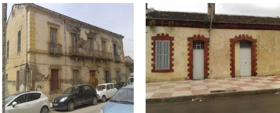
Figure 1.16 : Structures en maçonnerie.
