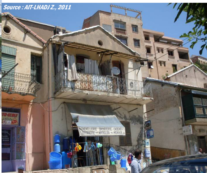
Photo 14: Vue sur immeuble renouvelé à A.E.H (B rd Amirouche)
