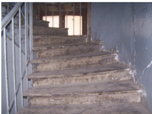
Photo 2.12. Marche d'escalier en bois.
