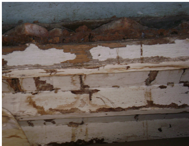
Photo 2.4. Remplissage en brique de terre cuite hourdée avec de la terre crue.
