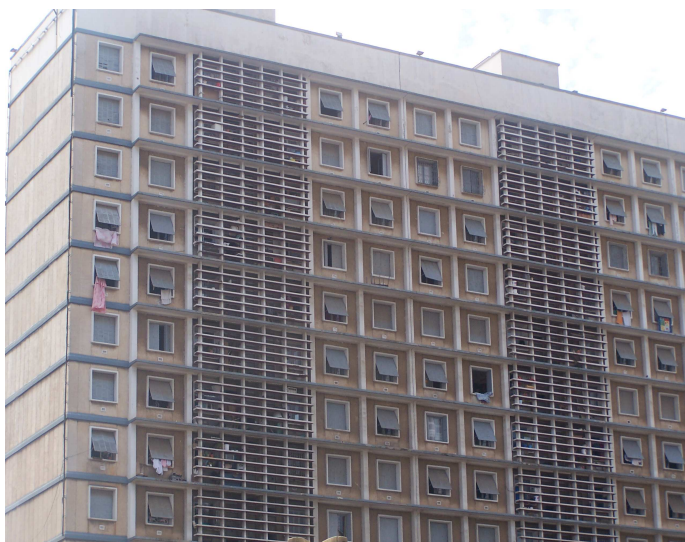
Photo 2.15. Remplissage de façade en panneaux préfabriqués en béton armé.
