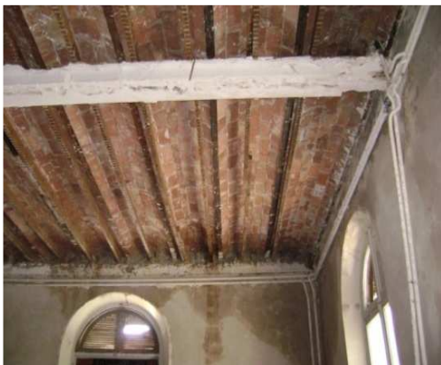
Figure 4 : Plancher à ossature métallique.
