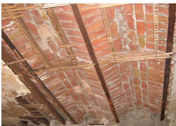
Photo 2.5. Plancher à vouîtain avec brique creuse et faux plafond.
