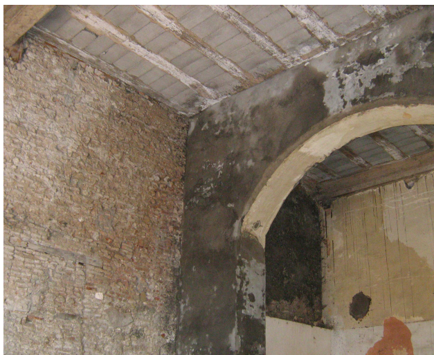
Photo 2.8. Mur porteur en maçonnerie en brique de terre cuite (plancher refait).
