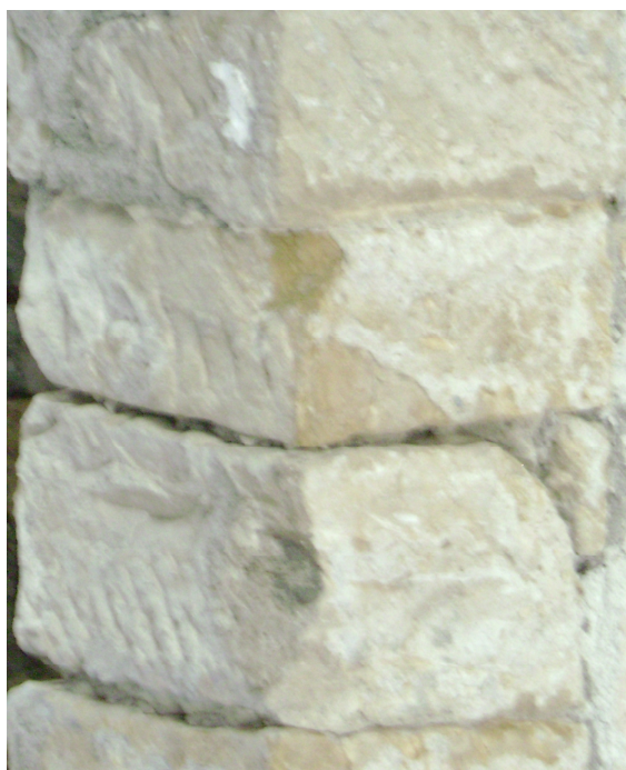
Photo 2.9. Mur homogène en maçonnerie de pierre.
