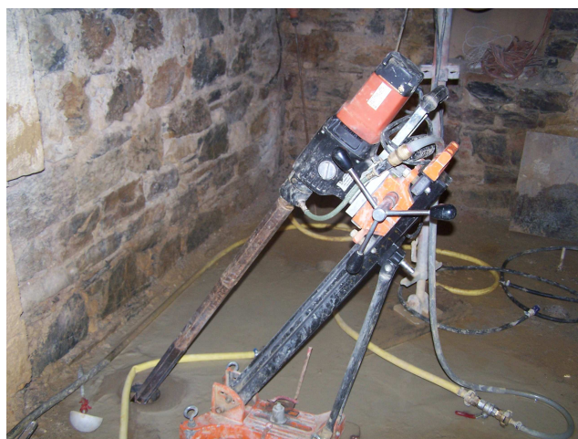
Photo 4.1. Réalisation de tirant d'ancrage à la basilique Notre-Dame d'Afrique.
