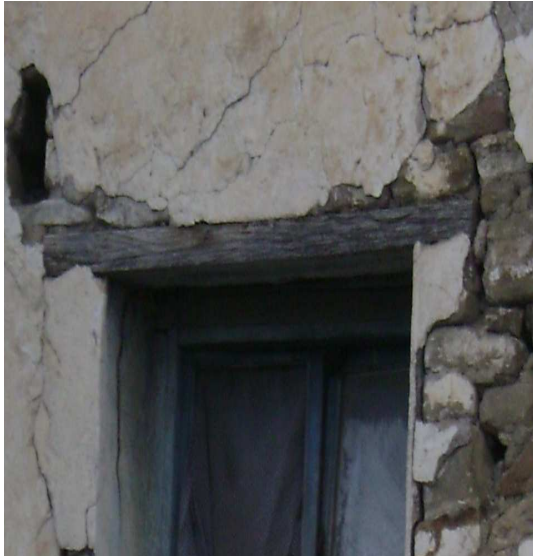
Photo 2.16. Linteau en bois.
