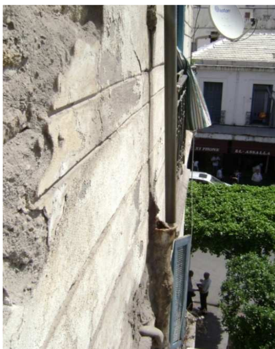
Photo 3.4. Effritement et écaillage des enduits.
