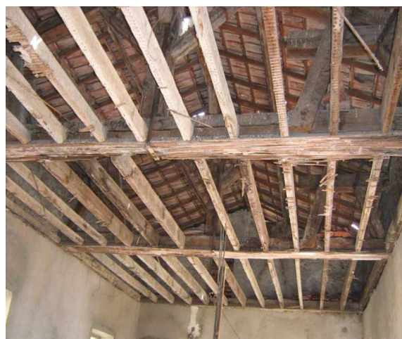
Photo 2.7. Charpente traditionnelle en bois.
