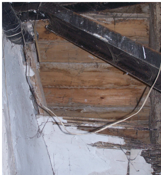
Photo 2.13. Revêtement de la face inférieure de l'escalier en bois.
