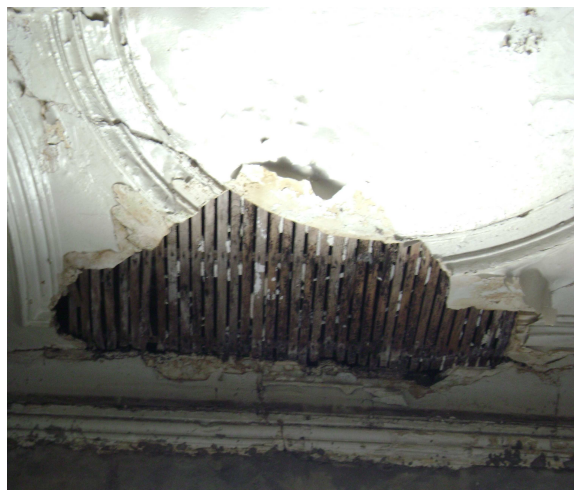
Photo 2.2. Faux-plafond en plâtre avec lattis.
