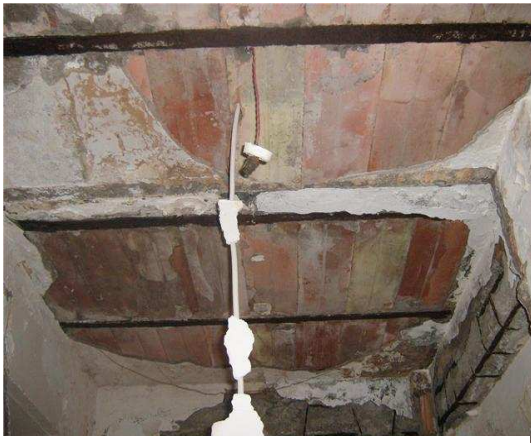
Photo 2.6. Brique creuse posé à plat.
