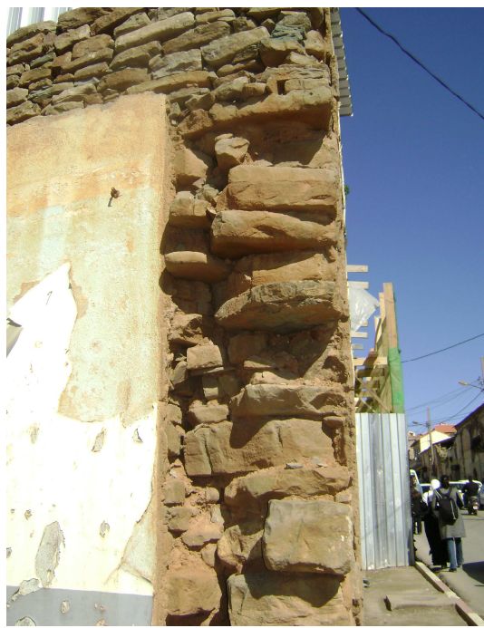
Photo 2.10. Mur composite en moellon.
