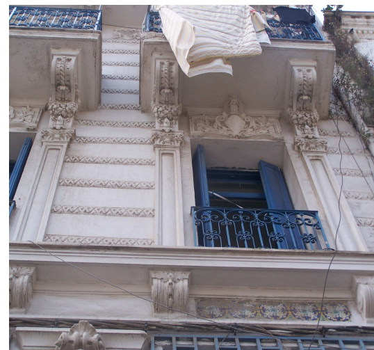
Photo 2.21. Mouluration en plâtre sur le long de la façade.
