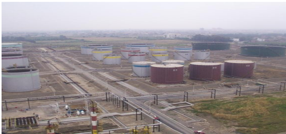
Figure 1. 4 : Parc de Stockage de la raffinerie d'Alger
