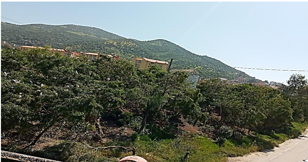
Figure 17 : La première colonie de la station de Boukhalfa (originale, 2022).
