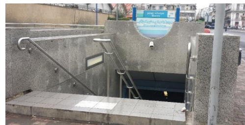
Fig.87: bouche de métro au niveau de l'arsenal Source : Auteurs le 03/02/2018
