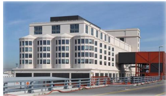
Fig. 24: Vue sur silo à céréales d'Arenc, Marseille source : https://www.ponts.org/fr/agenda/3003
