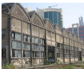
Fig.128 : bloc A Atelier de montage
