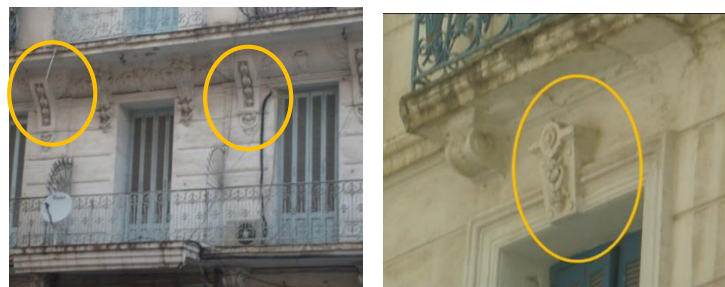
Fig.124: Détail architecturale ornements floraux Source : Auteurs le 03/02/2018
