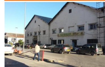
Fig.73: hangars industriels Source : auteurs le 17/01/2018
