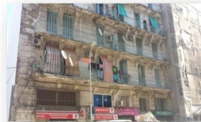
Fig.72: bâti haussmannien Source : auteurs le 17/01/2018
