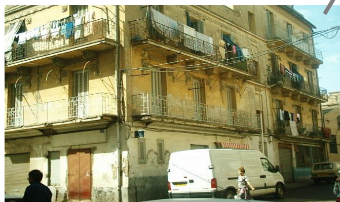
Habitat collectif en mauvais état
