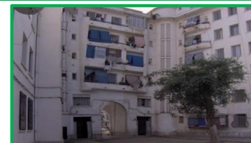
Fig.94:espace centrale non aménagé au niveau des HLM Source : Auteurs le 19/02/2018
