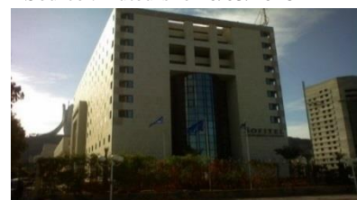
Fig.140: Hôtel SOFITEL Source : Auteurs le 12/03/2018
