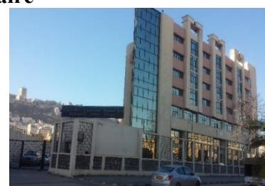
Fig.142 : entreprise métro d'Alger Source : Auteurs le 12/03/2018
