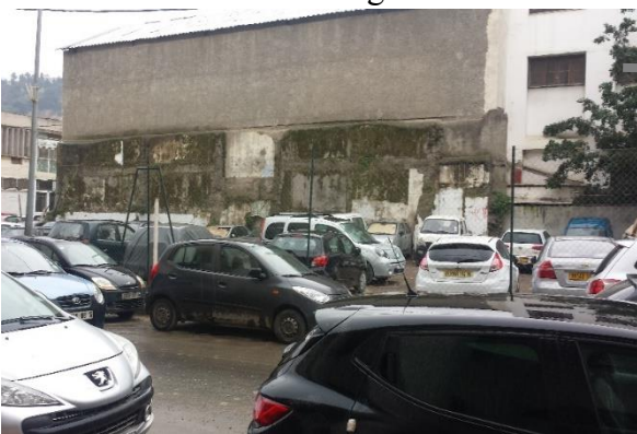
Espace perdue actuellement récupéré pour un parking
