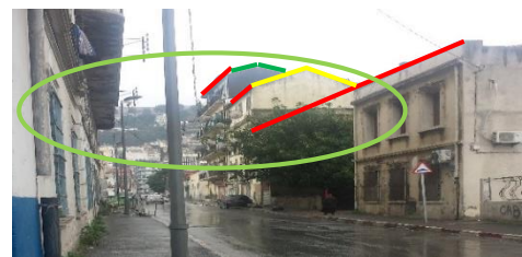
Fig.110 : vue sur la rue bouda Abdelkader source : Auteurs 03/02/20018
