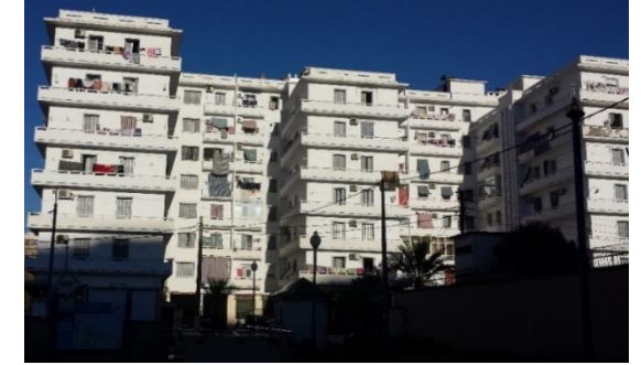
Bâti en très bon état
