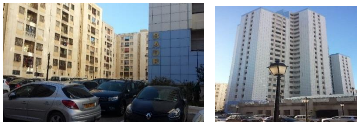
Fig.122: vue sur les halls Source : Auteurs le 20/03/2018
