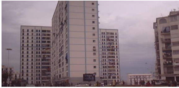
Bâti HLM en bon état
