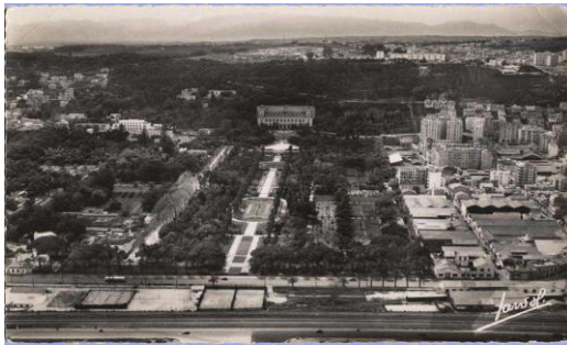
Fig.61: Carte postale les entrepôts du côté du jardin d'essai Source : http://cetaitlabaslalgerie.eklablog.fr
