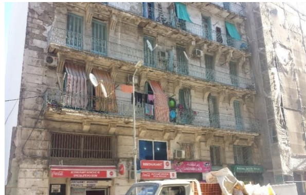
Des opérations de réhabilitation sont prévues pour l'habitat collectif au long de la rue Hassiba
