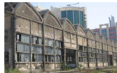
Fig.08 : friche ferroviaire (SNTF) source : Auteurs Le 09/02/2018
